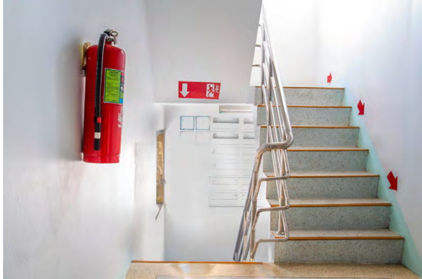
Görsel 3.8: Yangın anında tahliye
