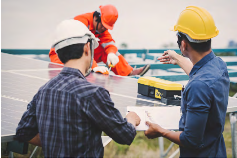
Görsel 2.2: Güneş enerjisi (fotovoltaik) proje kontrolü
