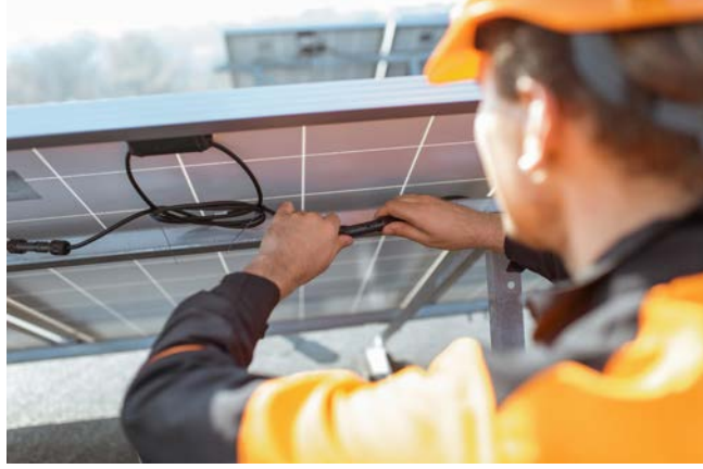
Görsel 2.24: Fotovoltaik santraldeki modüllerin bağlantısı
