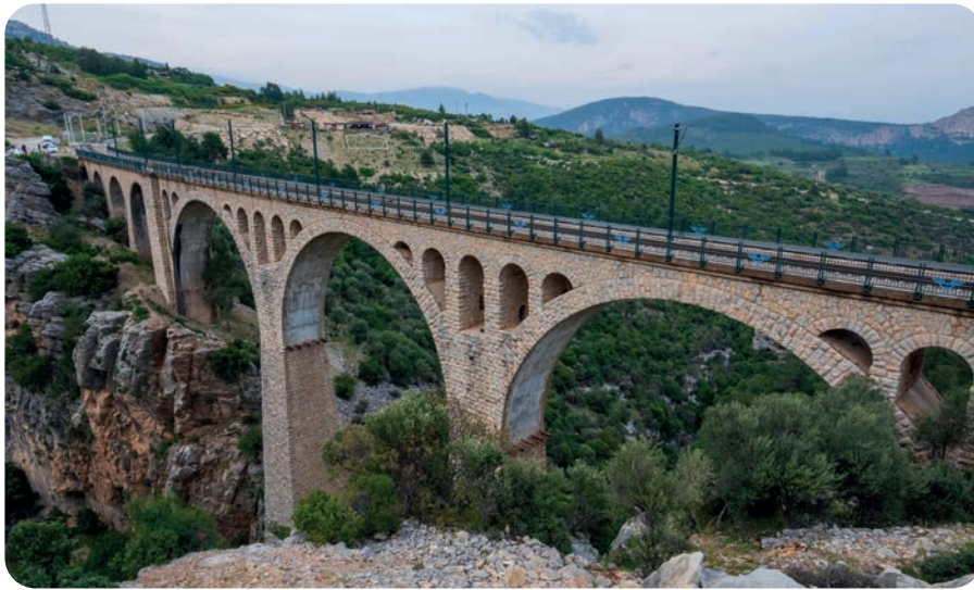
Görsel 6.5: 1. Dünya Savaşı esnasında inşa edilen Varda Demir Yolu Köprüsü
