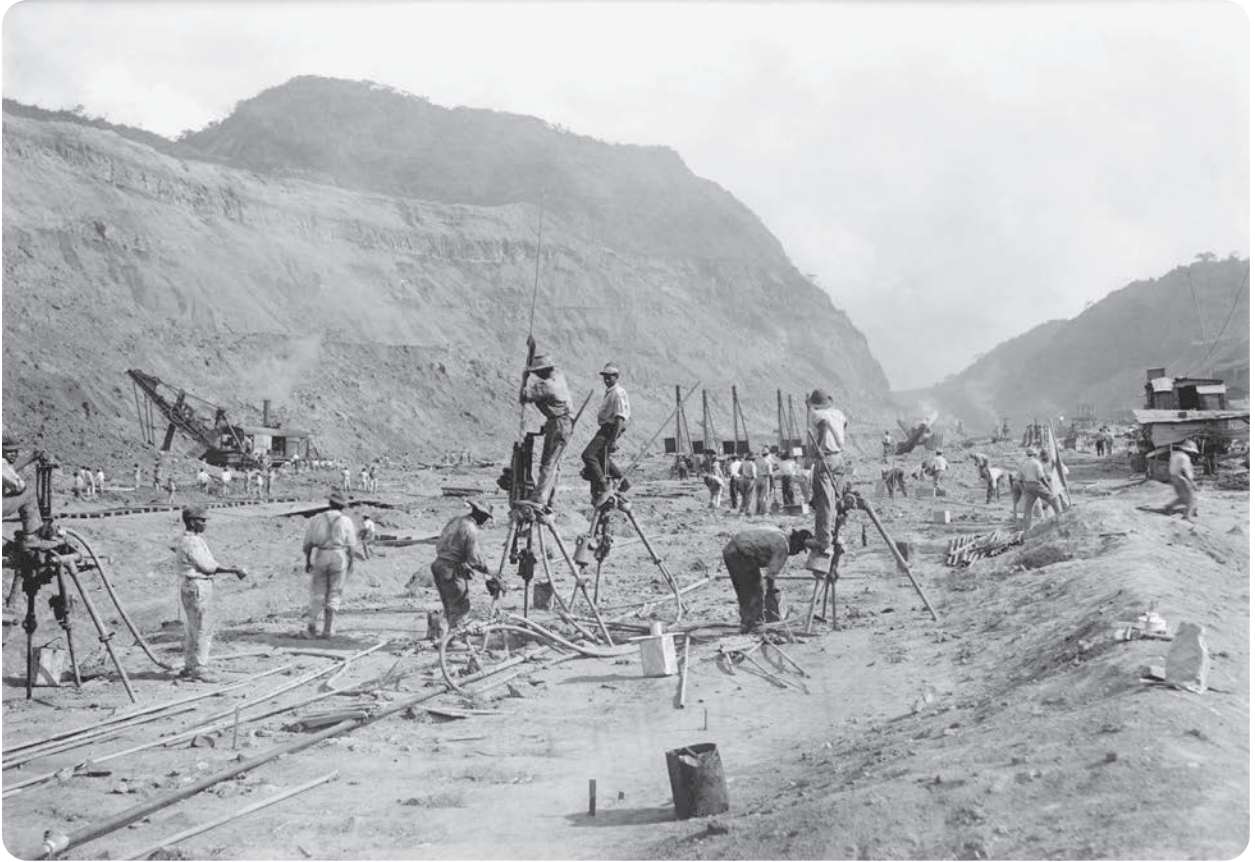
Görsel 3.13: Panama Kanalı inşa edilirken
