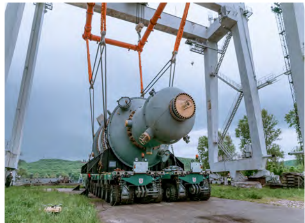
Görsel 1.43: Gantry vinç yükleme ve boşaltma işlemleri
