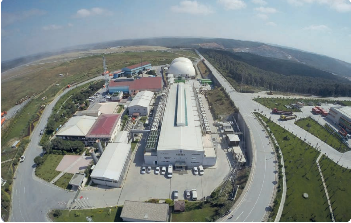
Görsel 2.26: Şile-Kömürçüoda endüstriyel katı atık tesisi
