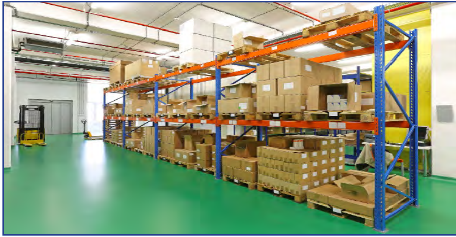
Görsel 5.18: Depo havalandırma sistemleri
