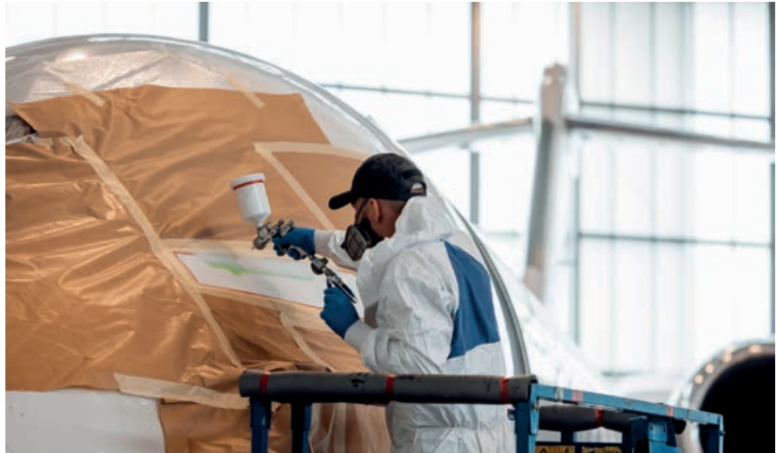
Görsel 5.24: Püskürtme yoluyla boyama işlemi
