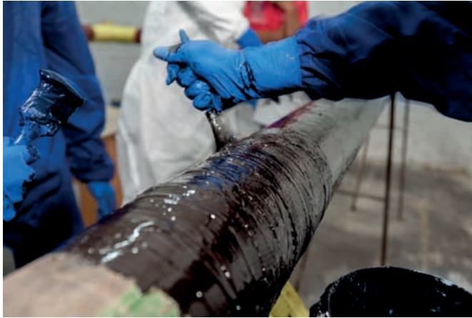
Görsel 1.16: Elyaf sarma yöntemi
