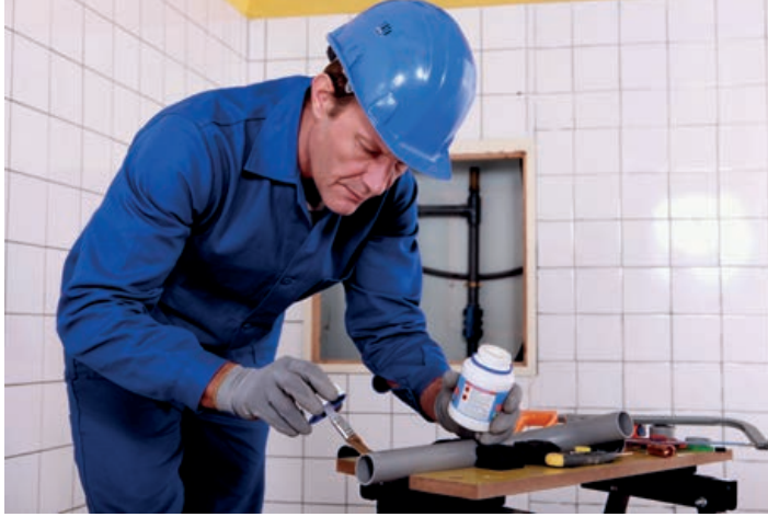
Görsel 4.27: Yapıştırma uygulaması
