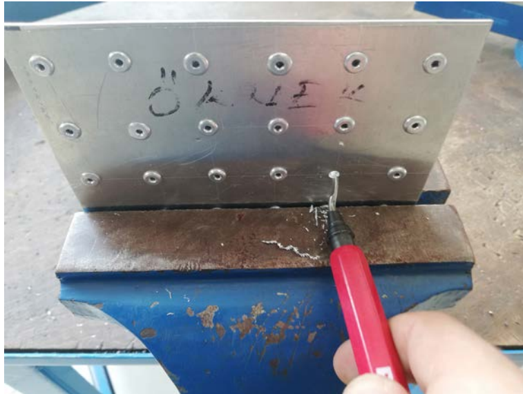
Görsel 3.31: Perçin deliğinin temizlenmesi
