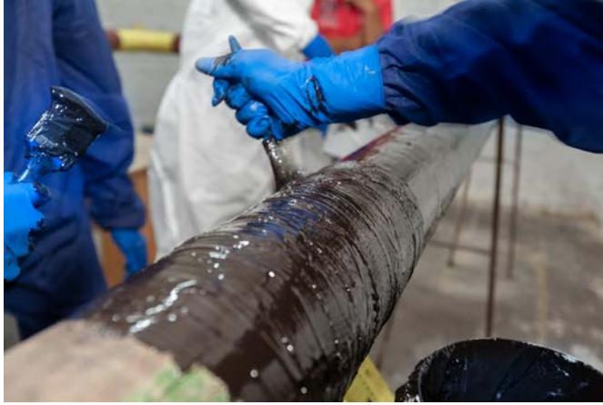
Görsel 1.16: Elyaf sarma yöntemi
