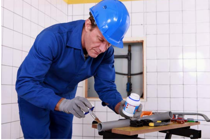
Görsel 4.27: Yapıştırma uygulaması
