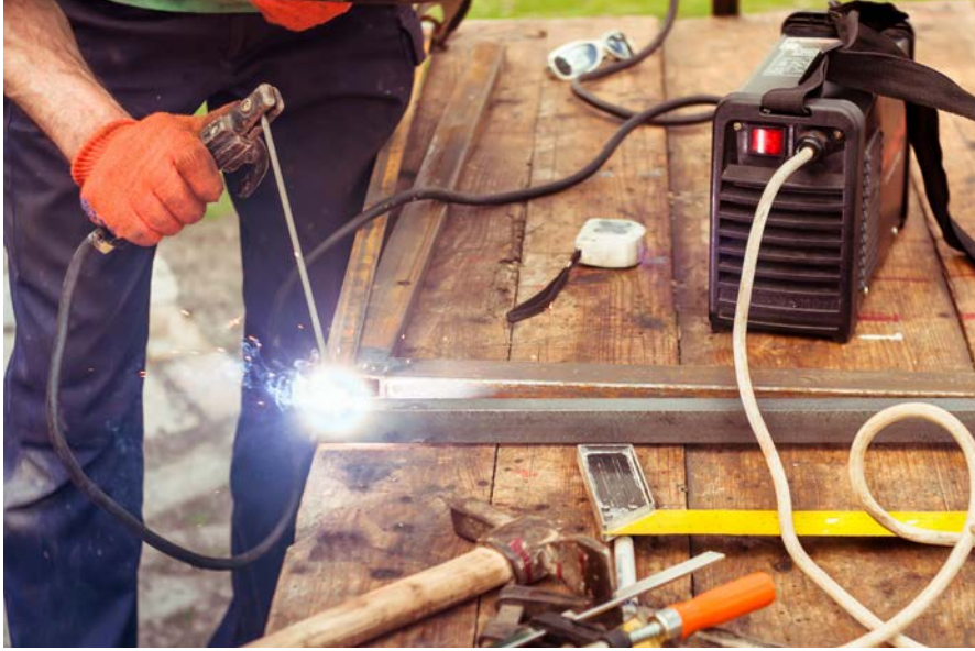
Görsel 4.25: Elektrik kaynađı uygulaması
