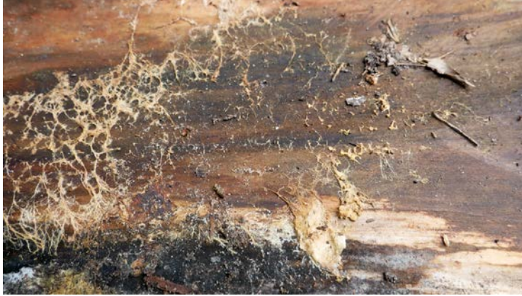
Görsel 1.24: Çürümüş ahşap örneği
