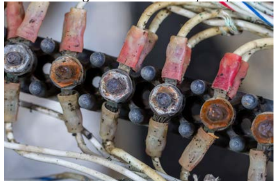
Görsel 5.28: Gözle kontrolde tespit edilebilecek olumsuz durumlara örnekler
