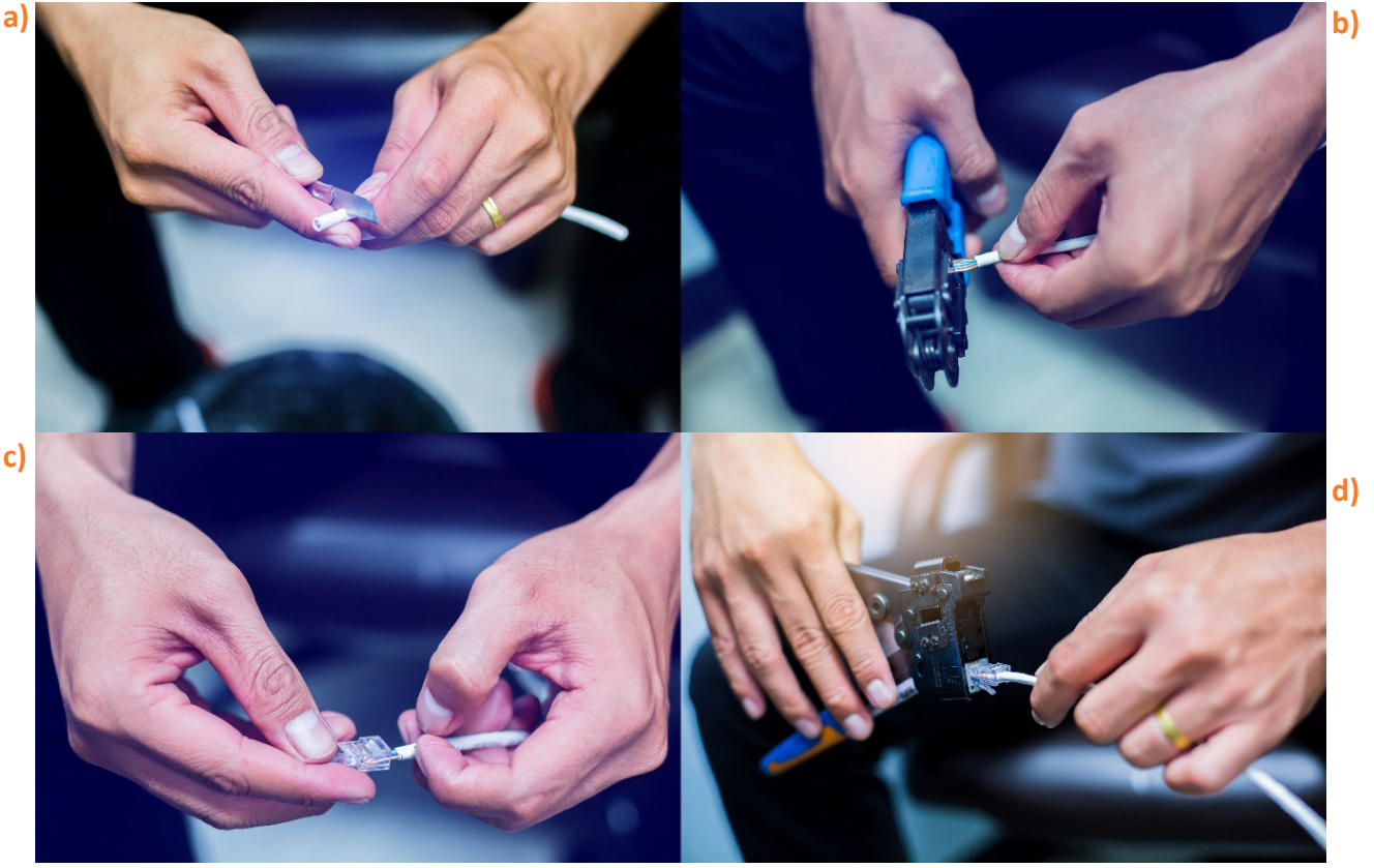
Görsel 5.21: RJ45 soket bağlantısının yapılması
