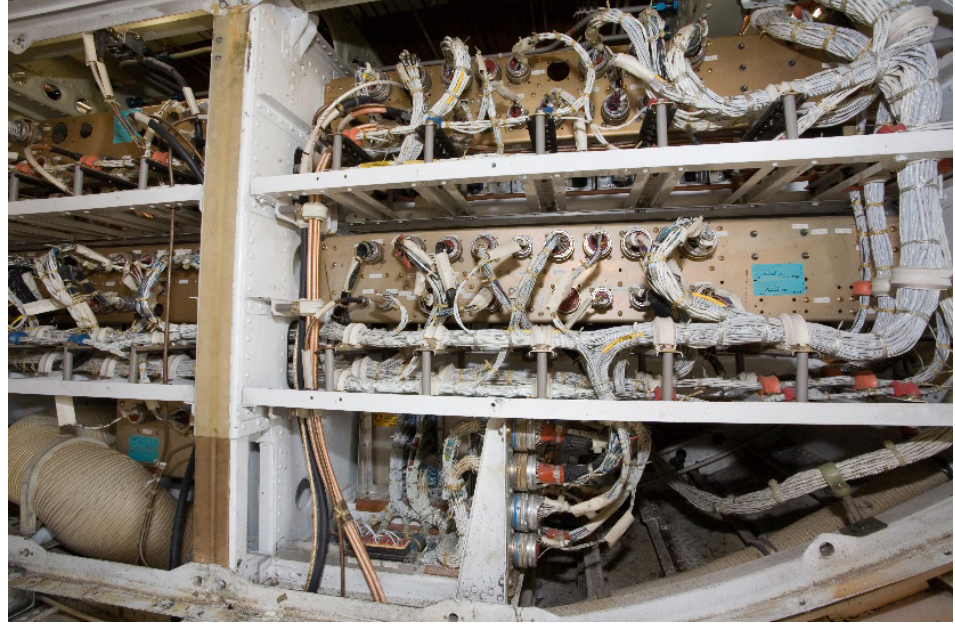
Görsel 5.38: Uçağın demetlenmiş kablo grupları
