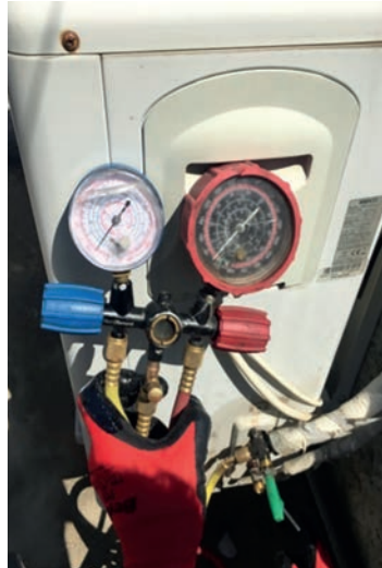
Görsel 8.4 Basma hattı vanasının kapatılması
