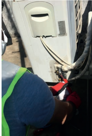
Görsel 8.7 Bakır boruların sökülmesi
