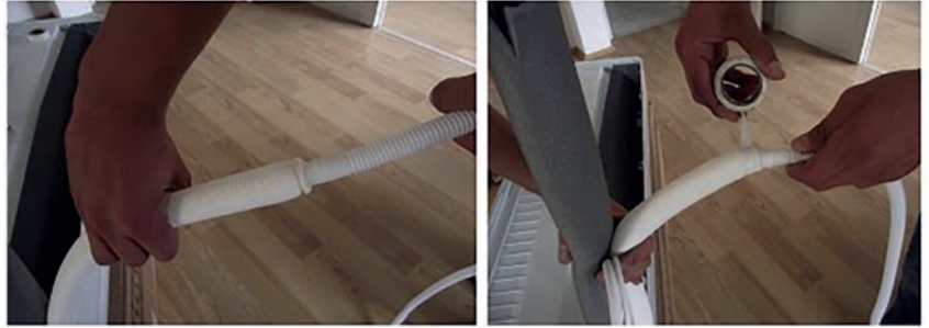
Görsel 7.12 İç ünite drenajına hortum ekleme
