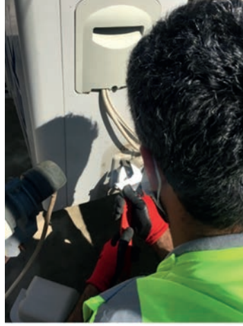
Görsel 8.2 Emme ve basma hattındaki kapakların sökülmesi
