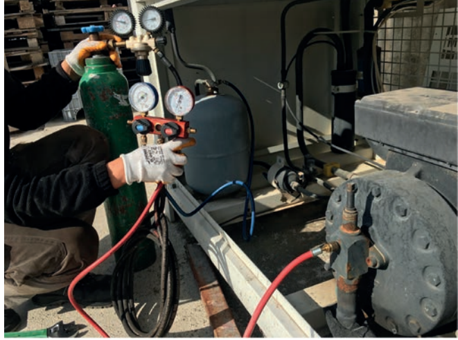
Görsel 5.8 Kaçak tespiti yapılan soğutma devresine azot verme
