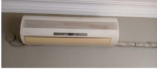
Görsel 7.22 Klima montajı
