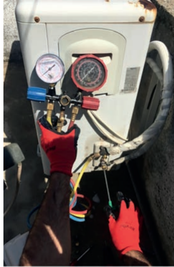
Görsel 8.3 Manifold bağlanması
