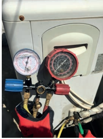
Görsel 8.5 Manifold üzerindeki basınç düşümü
