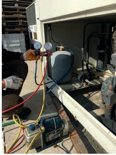
Görsel 4.20 Vakumlama işlemi
