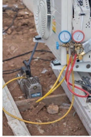
Görsel 7.31 Vakumlama işlemi
