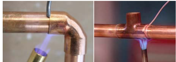
Görsel 4.6: Bakır boru lehimleme
