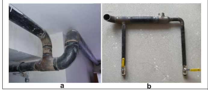
Görsel 2.6: Kaynaklı ve dişli birleştirme
