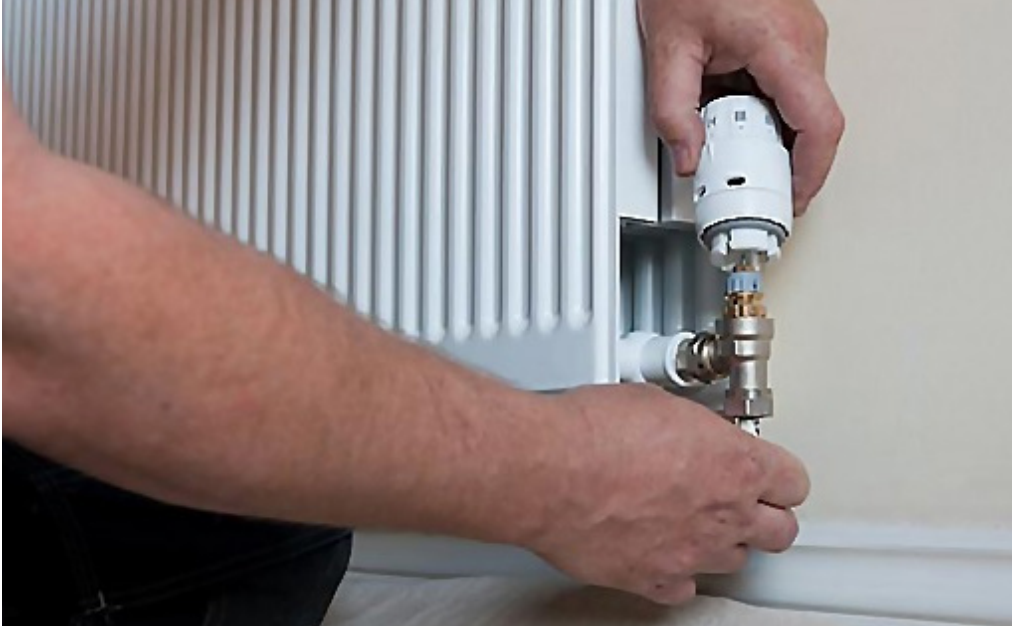
Görsel 9.31: Termostatik vana montajı
