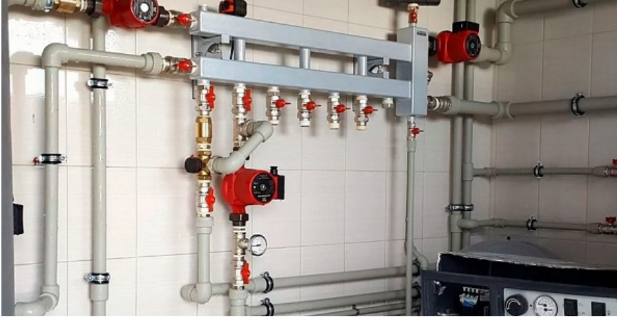
Görsel 10.11: Sirkülasyon pompası bağlantı şeması
