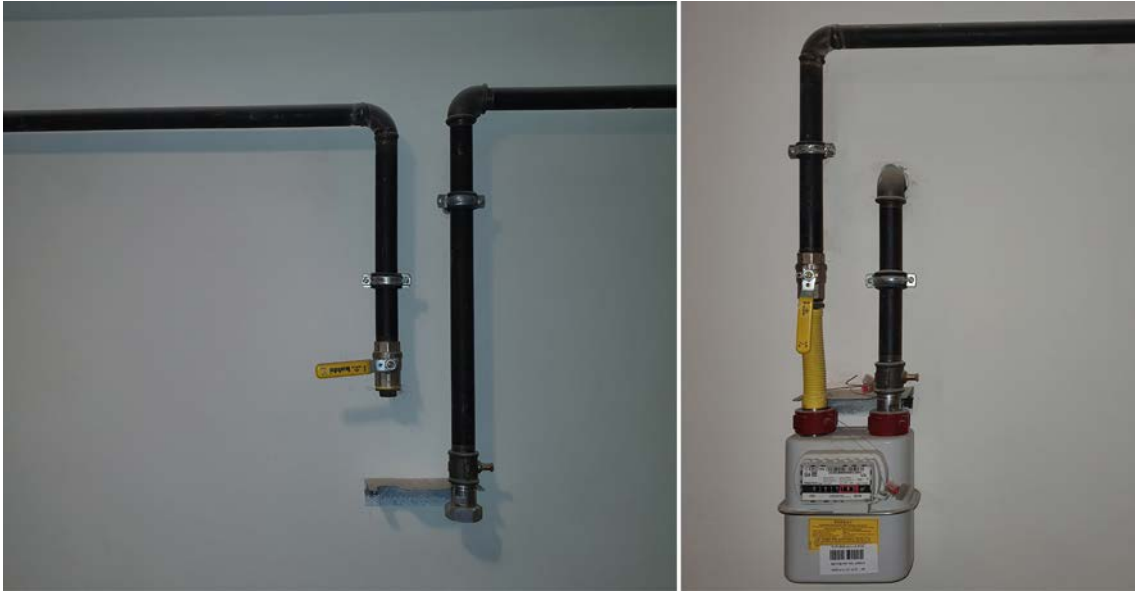
Görsel 3.22: Sayaç girişi küresel gaz kesme vanası montajı
