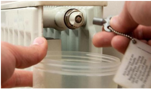
Görsel 9.25: Radyatör üzerinden hava alma vidası
