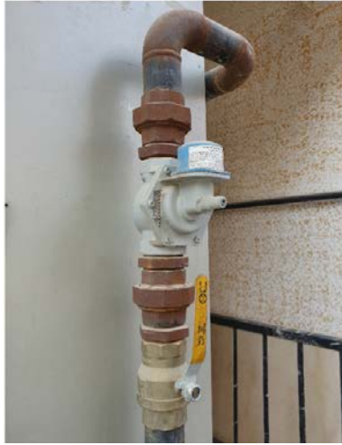
Görsel 3.10: Mekanik deprem vanası montaj şeması
