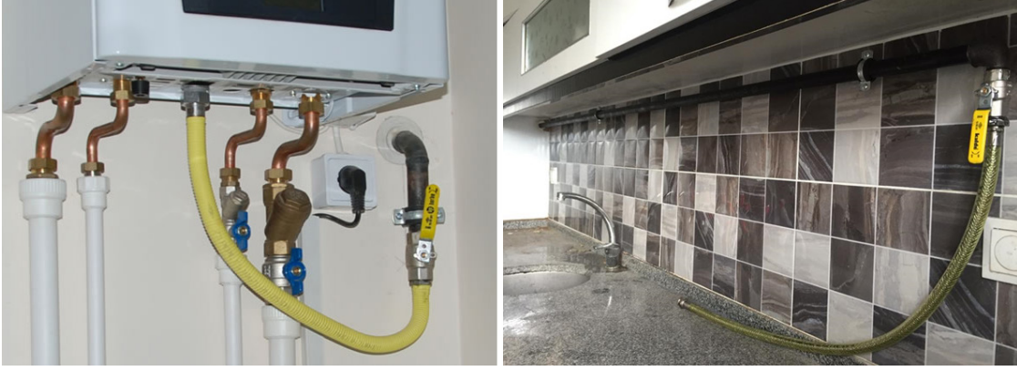
Görsel 4.13: Cihaz bağlantı hattı montajı
