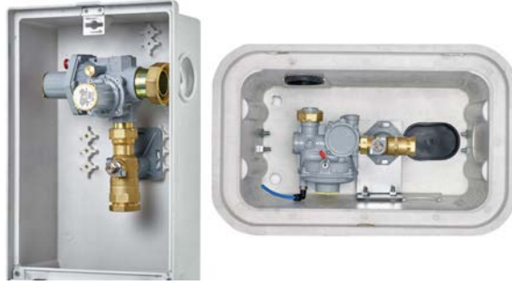
Görsel 2.24: Servis kutusu regülatör montaj uygulaması
