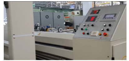
Görsel 6.13: Soğutma ve sıcaklık ayarının yapıldığı kısım
