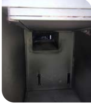
Görsel 6.34: a) Uçuntu ve tozların toplandığı filtre haznesi
