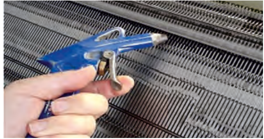
Görsel 5.16: Makine plakasının hava ile temizlenmesi
