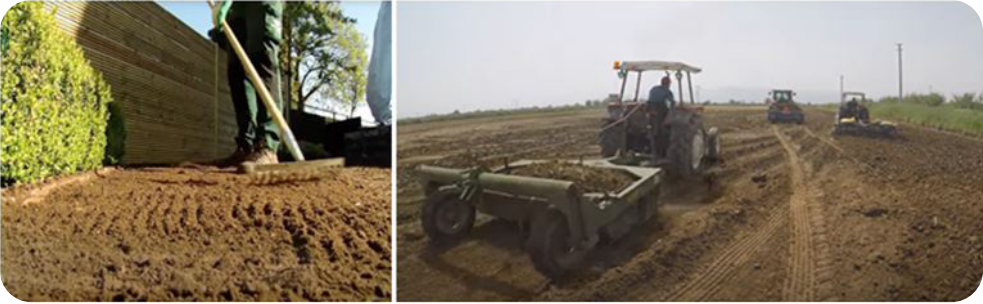
Görsel 11.3: Tirmık ve tesviye kürekleri ile kaba tesviye yapılması
