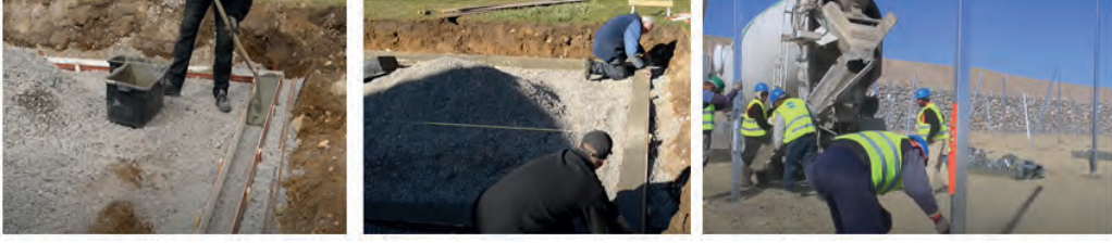
Görsel 4.4: Sera temellerine beton har doldurulması
