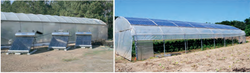
Görsel 4.21: Güneş enerjisinden yararlanarak sera ısıtma
