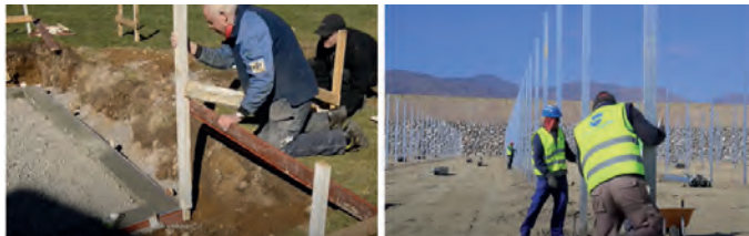
Görsel 4.3: Seranın temel kazıklarının çakılması
