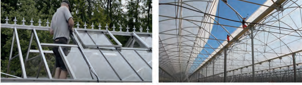
Görsel 4.8: Havalandırma pencerelerinin yapılması
