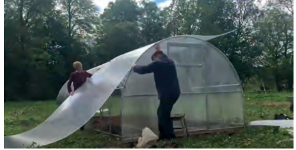
Görsel 4.11: Seranın polikarbon ile kaplanması
