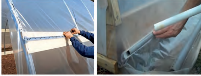
Görsel 4.14: Serada plastik örtünün kışkaç ile tutturulması
