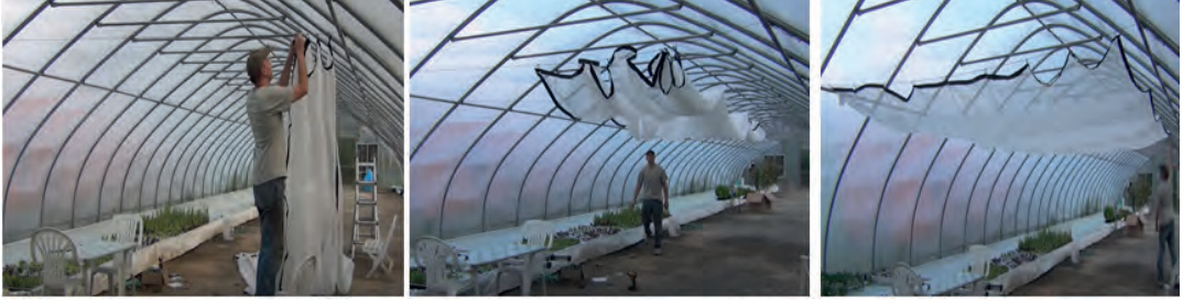
Görsel 4.26: Sera içerisinde gölgeleme perdesinin takılması
