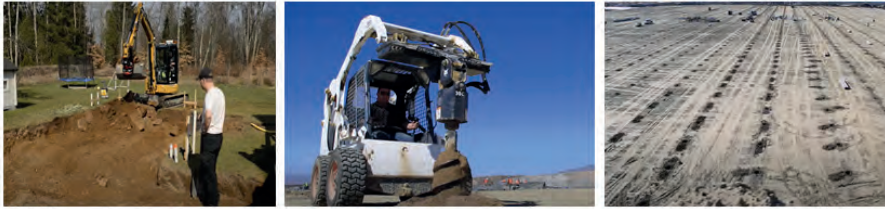
Görsel 4.2: Seranın temel çukurlarının açılması
