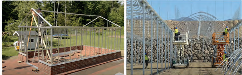
Görsel 4.7: Seranın kolon ve makaslarının bağlanması
