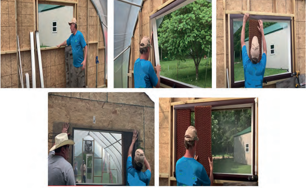
Görsel 4.32: Soğutma yastıklarıyla soğutma sisteminin kurulması
