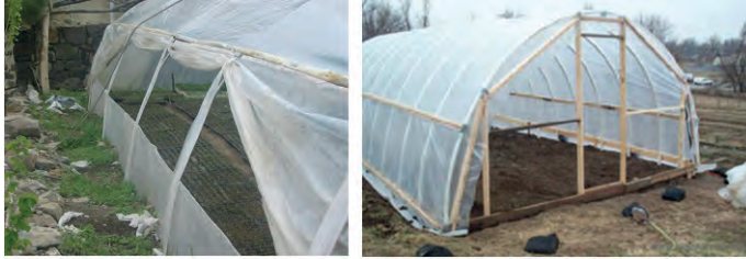
Görsel 3.28: Yüksek plastik tünellerde havalandırma ve kapı açıklıklarının bırakılması
