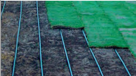
Görsel 5.85: Çim alanda toprak altı sulama sisteminin döşenmesi
