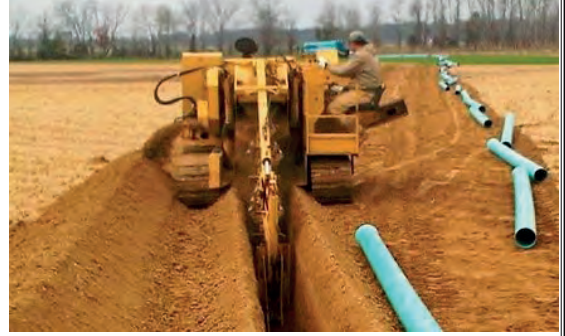
Görsel 5.83: Makine ile ana boru hattının açılması
