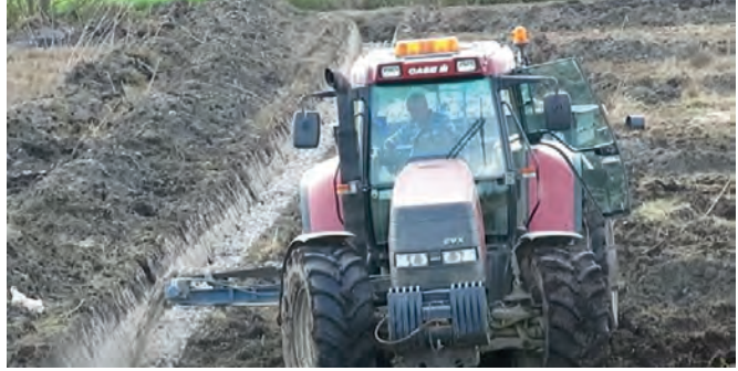
Görsel 3.13: Kanalların içine mıcır yerleştirilmesi
