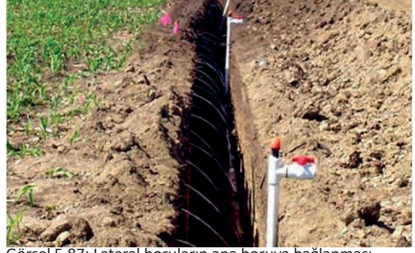
Görsel 5.87: Lateral boruların ana boruya bağlanması
