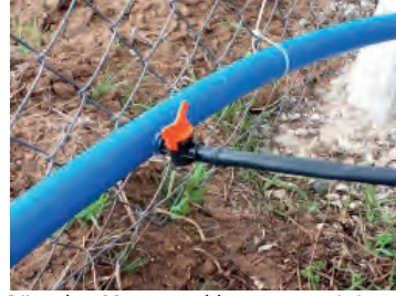
Görsel 5.63: Lateral borunun mini vanaya takılması
