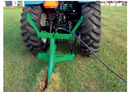
Görsel 5.86: Çim alanda toprak altı sulama sisteminin döşenmesi
