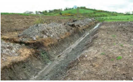
Görsel 3.9: Ana drenaj kanalları açılması
