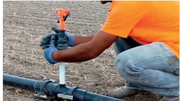
Görsel 5.76: Yağmurlama başlığının takılması
