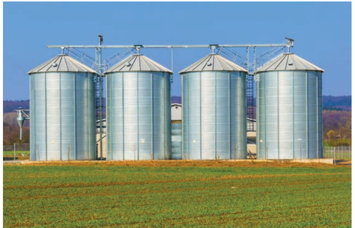
Görsel 3.11: Tahıl depolama siloları
