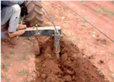
Görsel 5.47: Makine ile yer altı borusu döşemeleri
