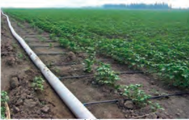
Görsel 5.28: Yan boru (manifold) hattı
