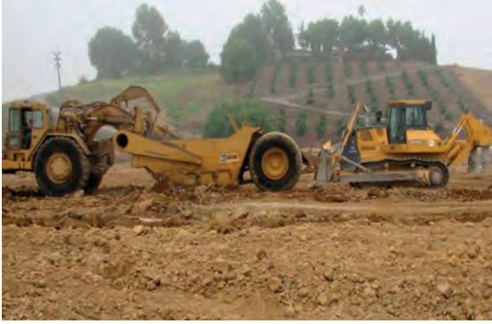
Görsel 3.18: Kaba tesviye işlemi
