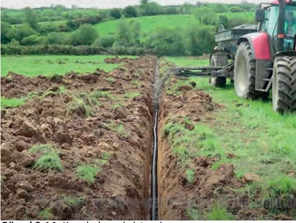
Görsel 3.14: Kapalı drenaj sistemi
