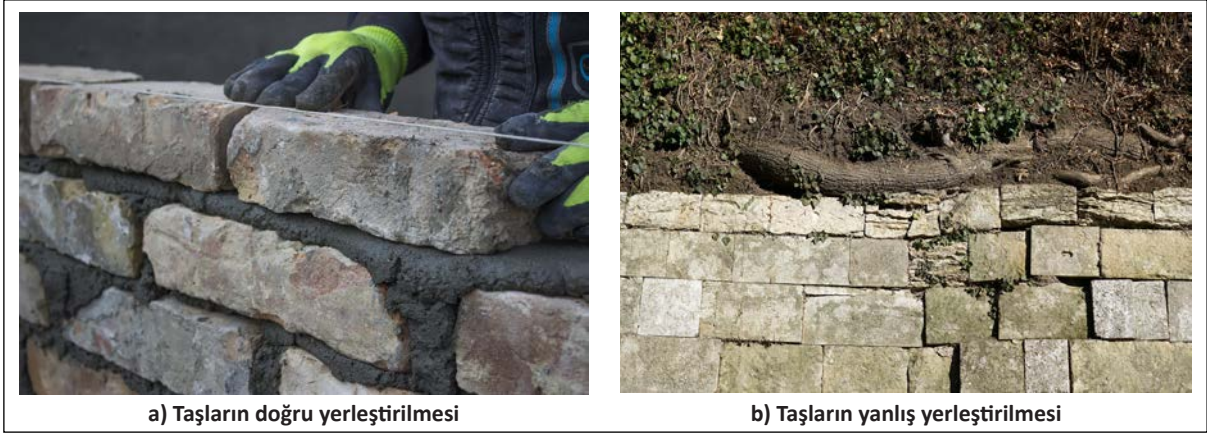
Görsel 1.51: Taşların doğru ve yanlış yerleştirilmesi
