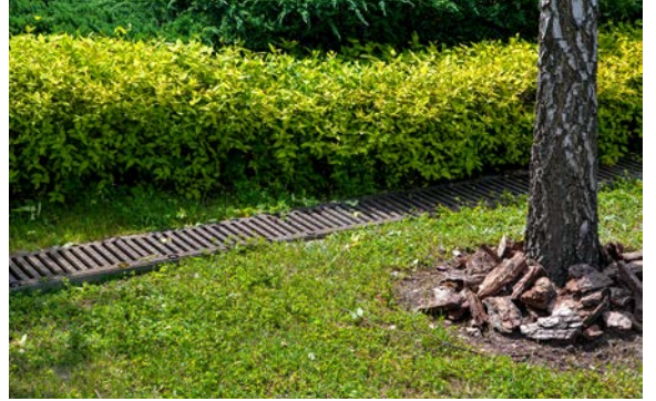
Görsel 1.23: Yüzey drenaj sistemi uygulanan bahçe
