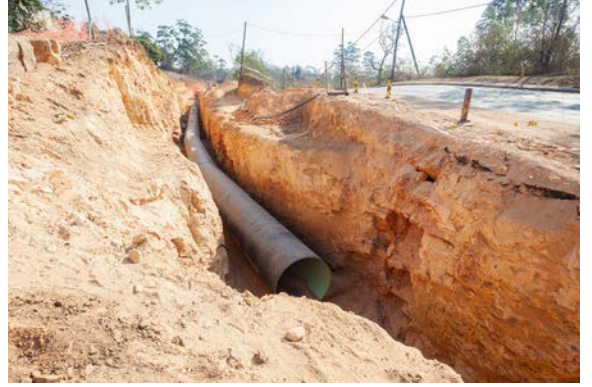
Görsel 1.47: Drenaj borularının hazırlanması
