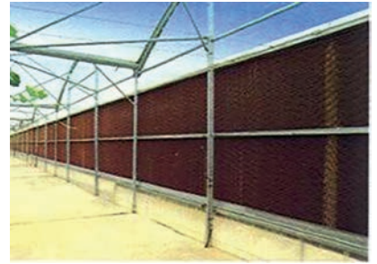
Görsel 2.85: Soğutma yastığı yerleştirilmiş sera
