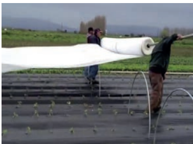
Görsel 1.25: Elle iskelet demirleri üzerine örtü serilmesi
