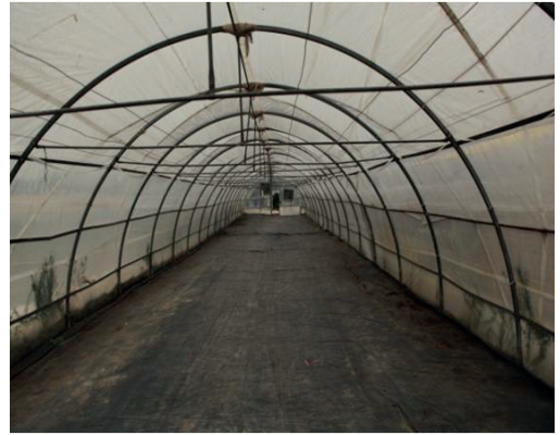
Görsel 1.33: Yüksek tünelin iskelet sisteminin içten görünüşü
