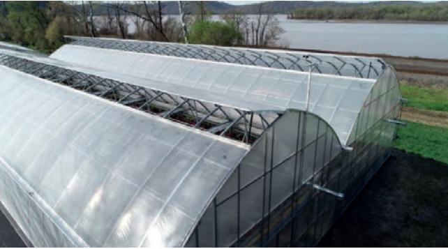
Görsel 2.43: Serada üst havalandırma açıklığı
