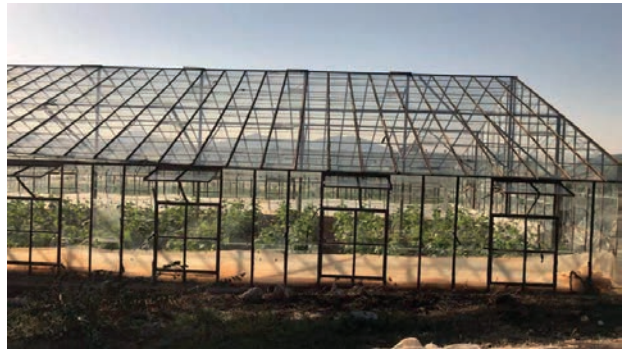
Görsel 2.80: Doğal havalandırma pencereleri
