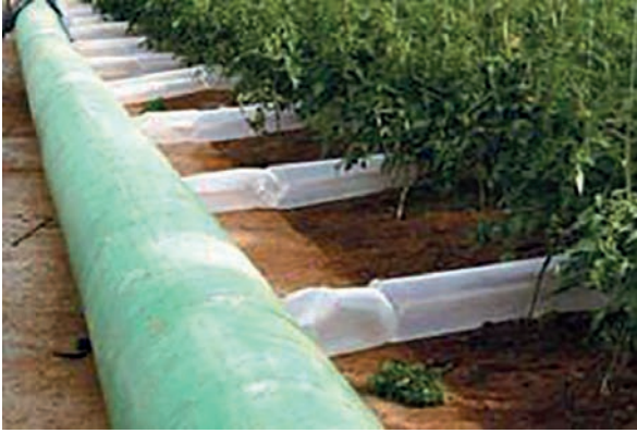
Görsel 2.70: Sıcak havayla ısıtma sistemi
