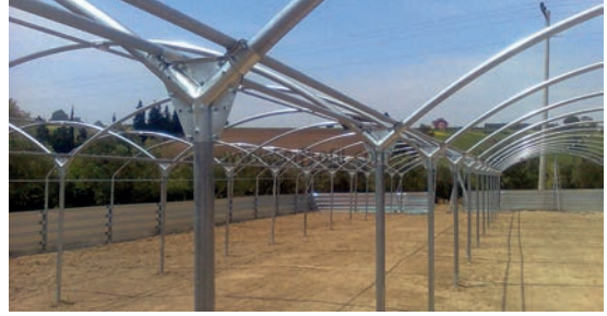
Görsel 2.33: Metal yapı malzemeleriyle kurulan sera
