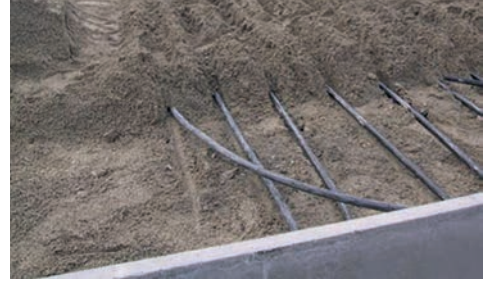
Görsel 2.69: Toprak içi ısıtma sistemi
