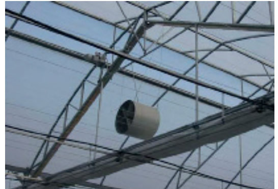
Görsel 2.82: Hava akımını hızlandırıcı vantilatör
