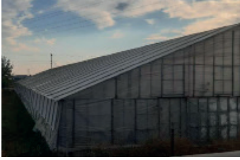
Görsel 2.20: Tek meyilli çatılı sera
