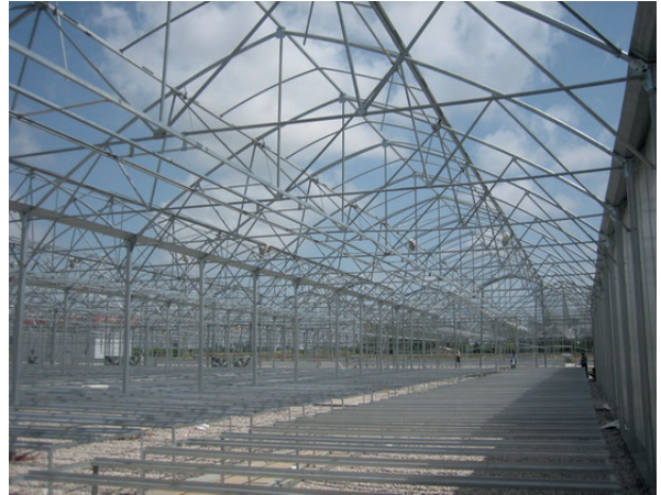
Görsel 2.34: Çatı makası, aşıklar ve mertekler
