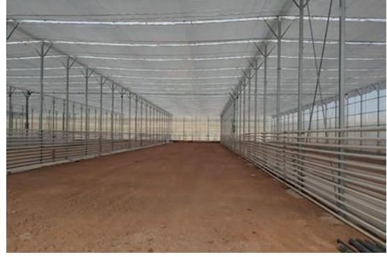
Görsel 2.66: Yan duvar borulu ısıtma sistemi
