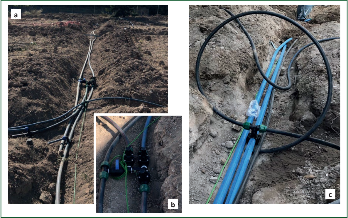
Görsel 3.13: a) Rulo çim serme (uygulama) alanında yağmurlama sulama sisteminin kurulumu b) Sulama hortumları birleşme detayı c) Sulama hortumları yerleşme detayı
