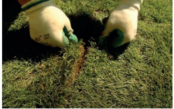
Görsel 3.25: Rulo çimlerin uç uca birleştirilmesi
