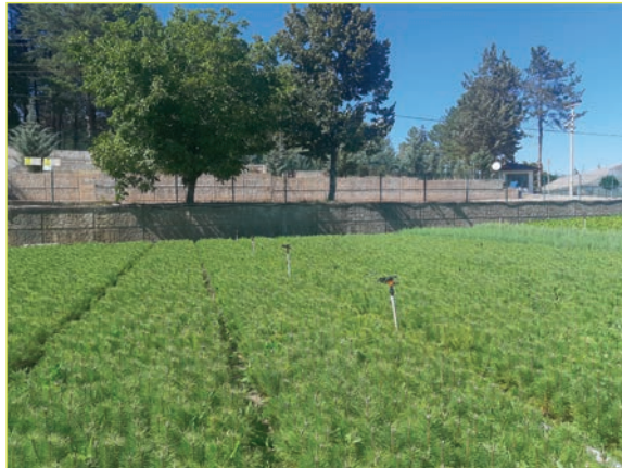
Görsel 1.9: Fidanlık etrafının duvarlarla çevrilmesi
