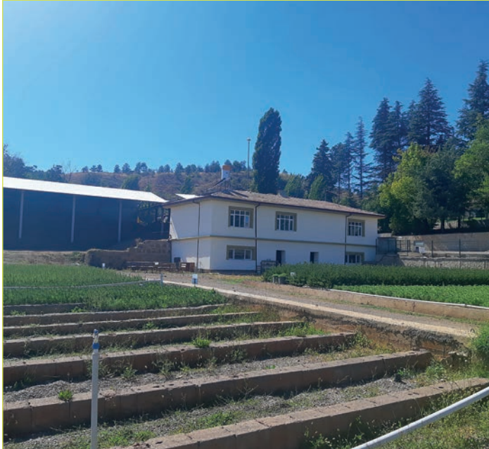
Görsel 1.24: Fidanlıkta işletme binası
