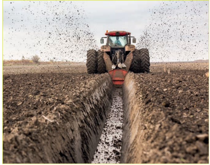
Görsel 1.10: Arazi drenajının yapılması
