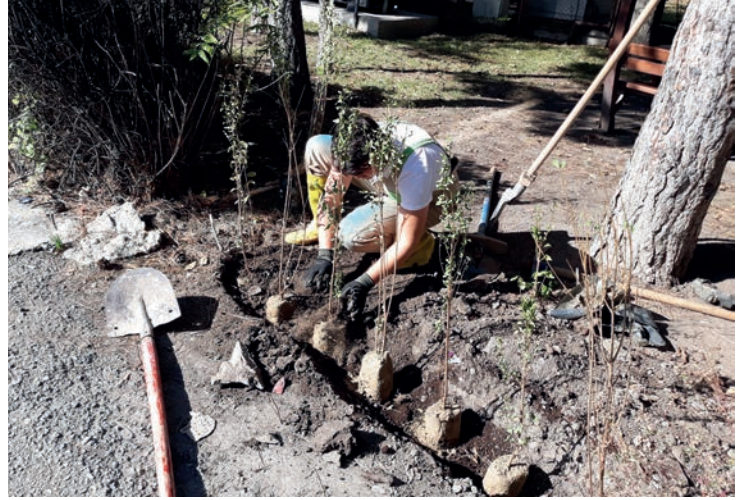
Görsel 4.14: Kanal şeklinde açılan çukurlara çit fidanlarının yerleştirilmesi
