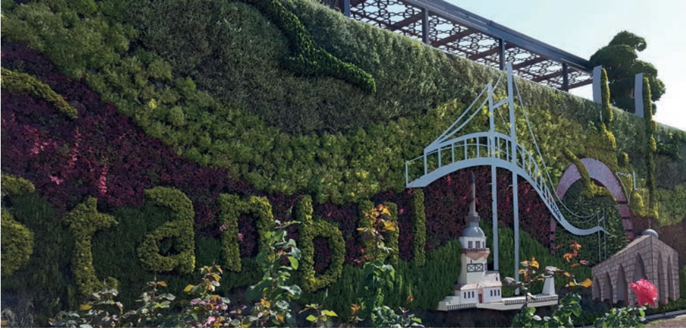
Görsel 5.1: Sarılıcı ve sürünücü bitkilerle yeşillendirilmiş dış cephe (dikey bahçe)
