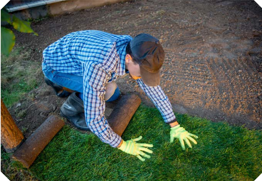
Görsel 3.2: Rulo çimin birleştirilmesi
