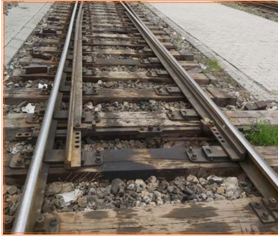
Görsel 3.16: Ahşap travers
