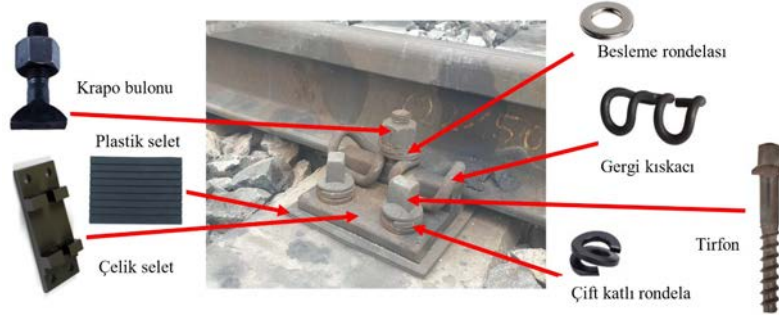
Görsel 3.21: KS tipi bağlantı malzemeleri
