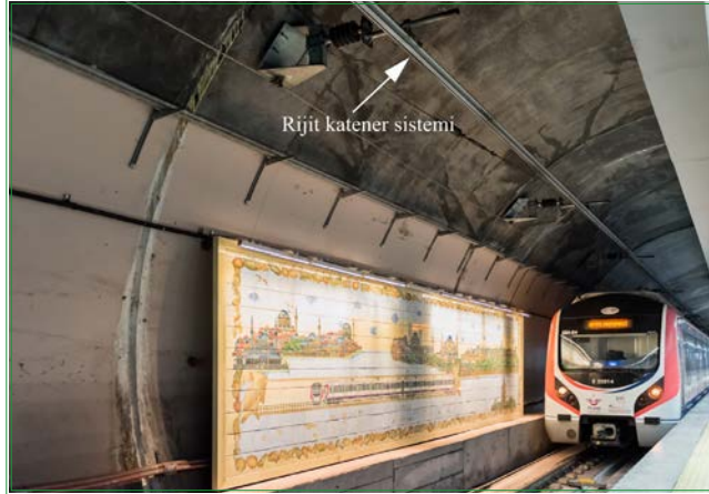
Görsel 4.19: Rijit katener sistemi (Marmaray Tüneli)
