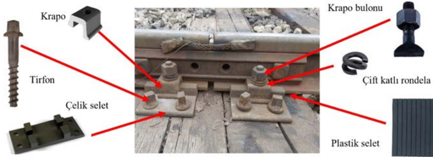
Görsel 3.19: K tipi bağlantı malzemeleri
