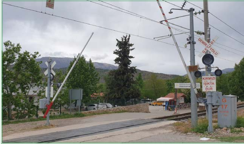
Görsele 4.5: Otomatik bariyerli hemzemin geçit (Geçiş açık)
