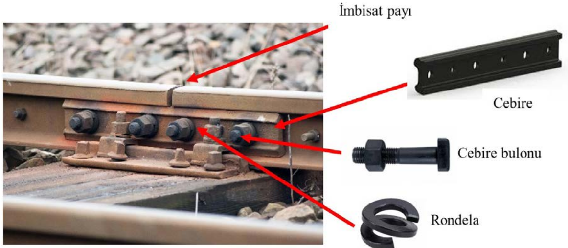
Görsel 3.18: Rayı raya bağlayan bağlantı malzemeleri
