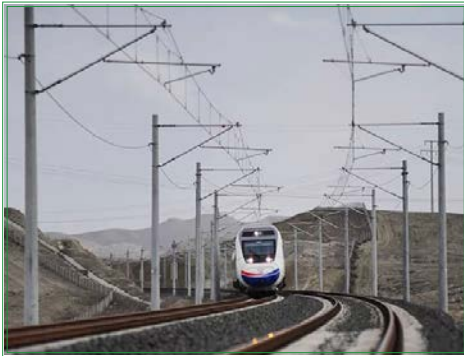
Görsel 4.17: Beton direkler
