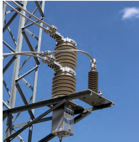
Görsel 3.149: Manyetik başlatmalı 27,5 kV kesici
