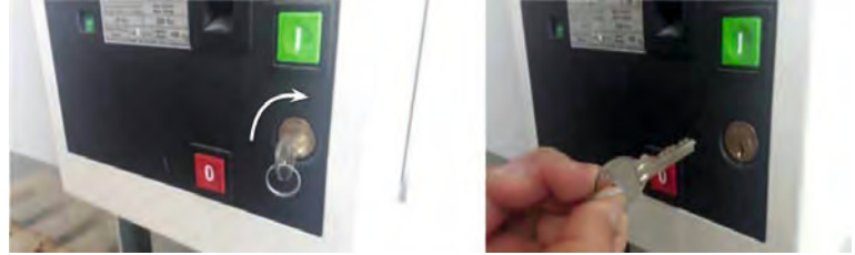
Görsel 3.95: Kesici mekanizmasının kilitlenmesi
