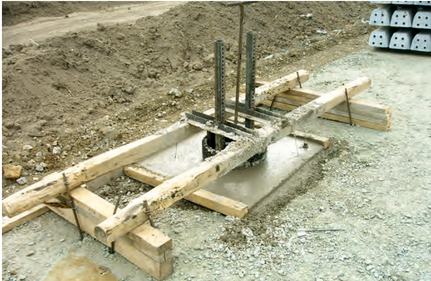
Görsel 4.8: Beton dökümü
