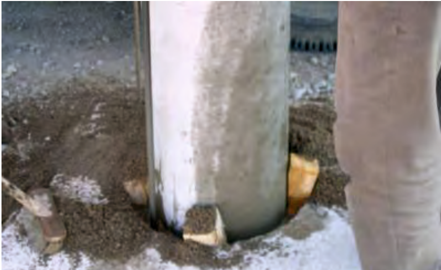
Görsel 4.10: Direğe takoz yerleştirilmesi
