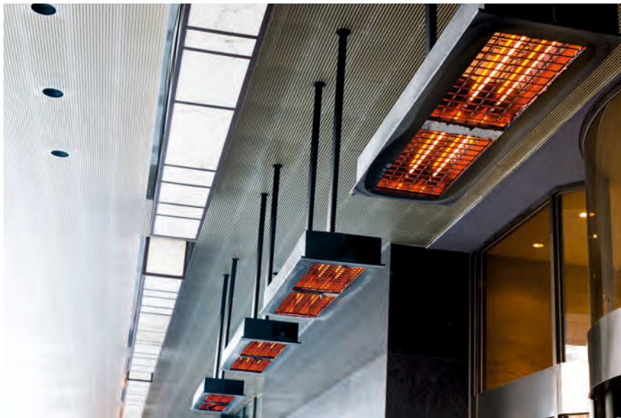
Görsel 1.25: Elektrik akımı ısı etkisi
