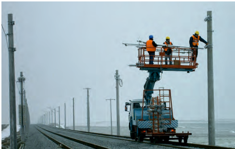
Görsel 4.15: Konsol hoban montajı
