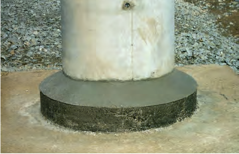
Görsel 4.11: Çember betonu
