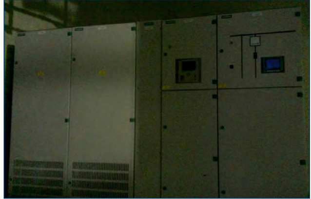
Görsel 3.165: DC şalt hücreleri MG01 ve MG02, MC11 ve MD51
