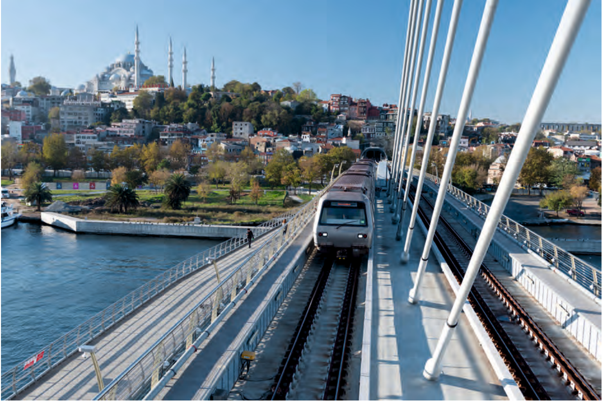
Görsel 4.66: İstanbul Yenikapı-Haciosman Metro Hattı üçüncü ray sistemi
