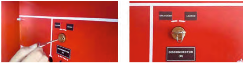
Görsel 3.96: Ayırıcı kilidinin açılması
