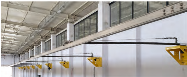
Görsel 4.61: Hareketli rijit katener sistemi
