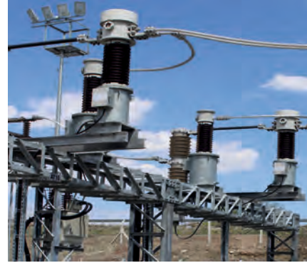
Görsel 3.151: Sekonder kısmı akım trafoları
