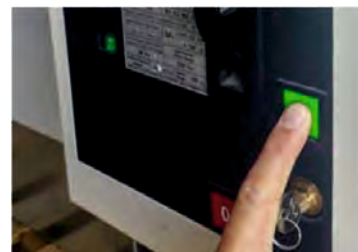
Görsel 3.92: Kesicinin kapatılması
