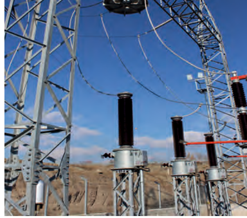
Görsel 3.141: Primer kısmı gerilim trafosu
