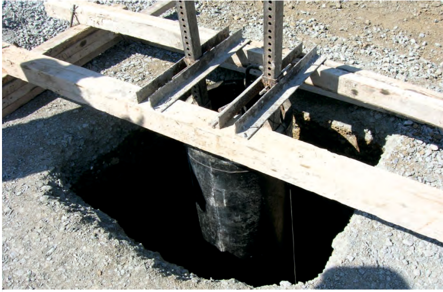
Görsel 4.7: Karotun yerleştirilmesi
