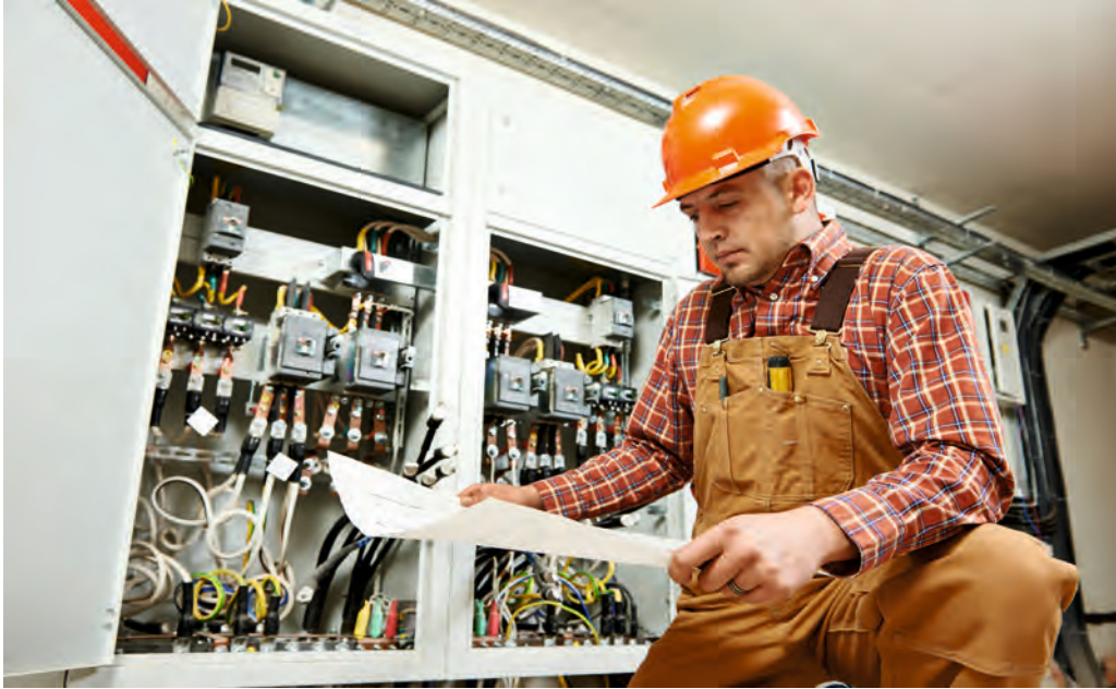
Görsel 3.130: Aşırı akım rölesi montajında proje incelemesi
