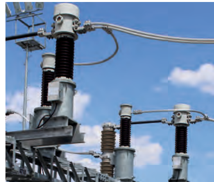
Görsel 3.152: Sekonder kısmı gerilim trafoları
