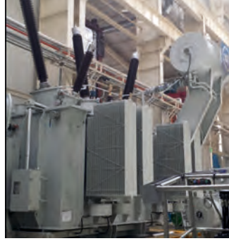
Görsel 3.19: ONAF soğutmalı transformatör
