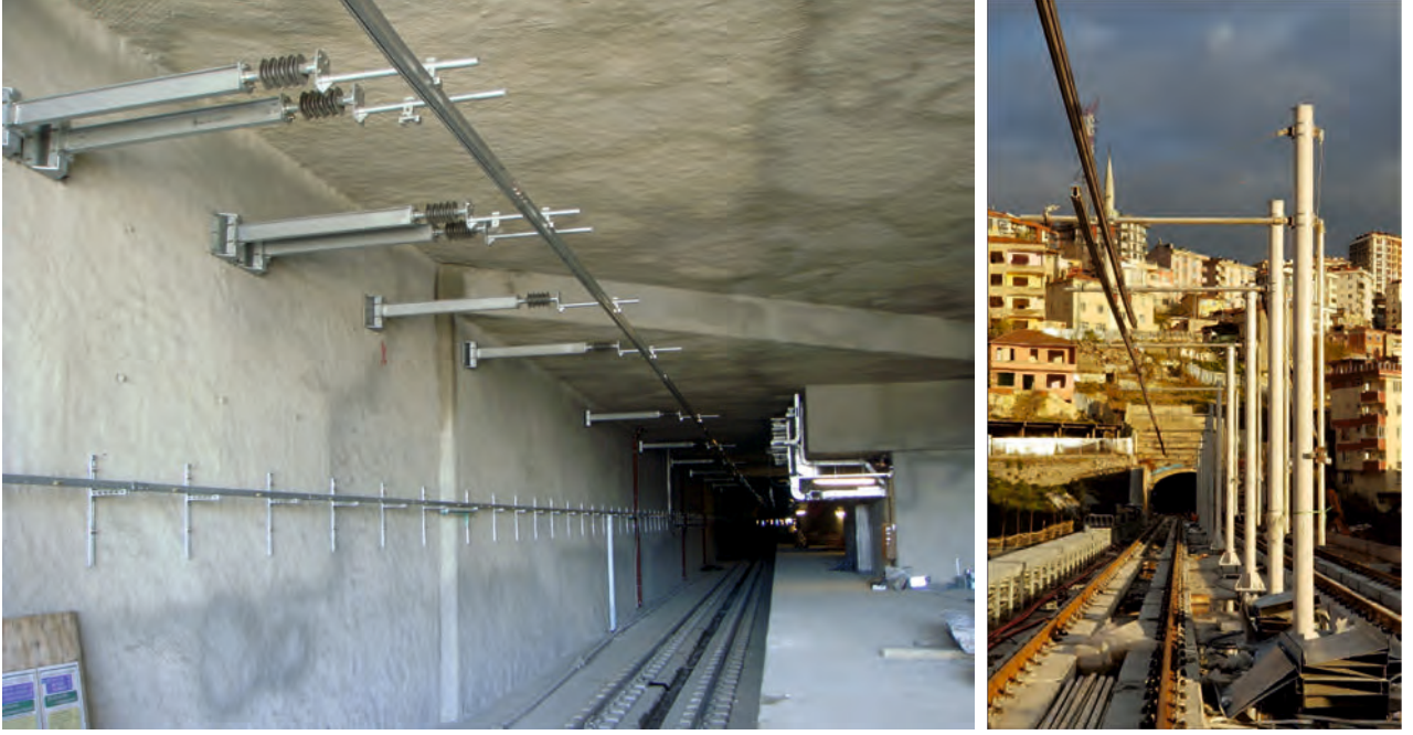
Görsel 4.56: Çeşitli destek elemanlarının kullanımı
