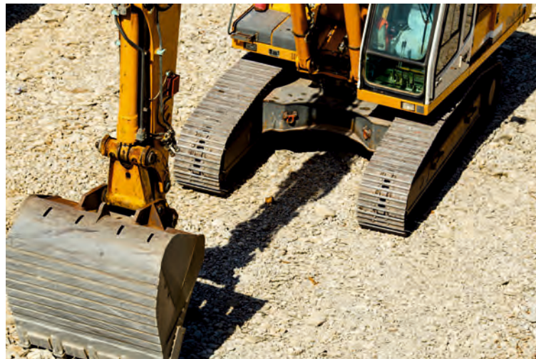
Görsel 4.6: Temel kazılması
