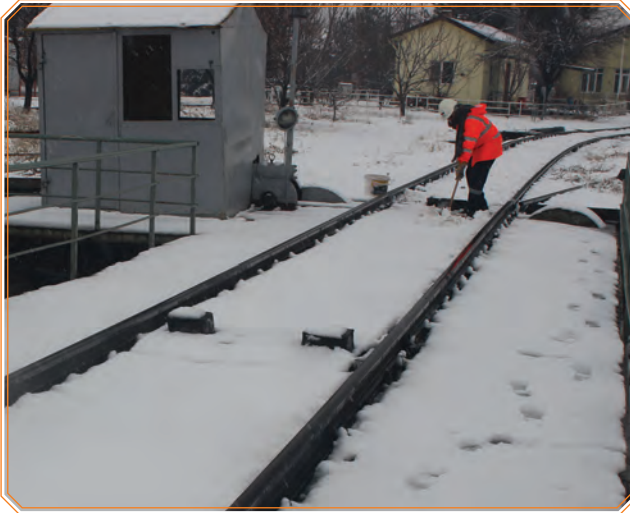
Görsel 6.10: a) Döner köprüünün temizlenmesi
