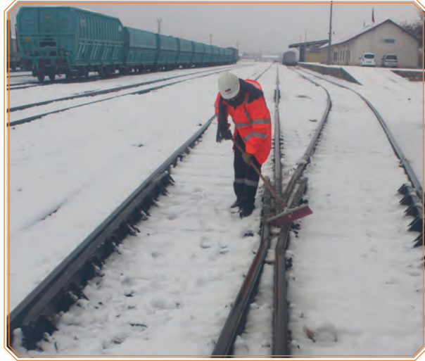
Görsel 6.5: Göbek ve kontrrayların temizlenmesi
