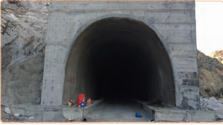
Görsel 2.23: Tünel yapımı esnasında bırakılan drenaj boruları
