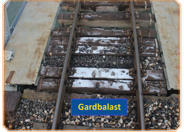
Görsel 3.14: Balast tutucu duvar
