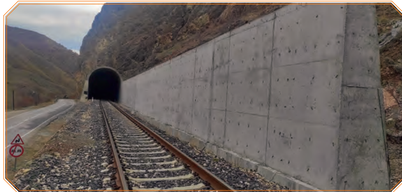
Görsel 12.9: Betonarme istinat duvarı
