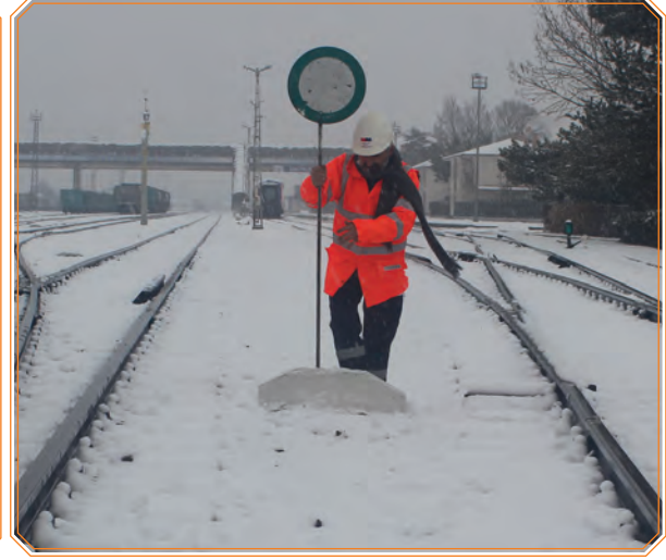
Görsel 6.8: Limit taşının yerinin diskle belirlenmesi
