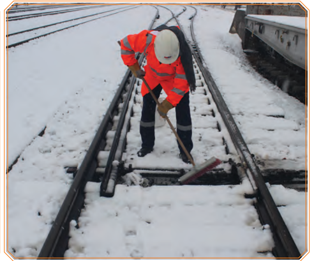
Görsel 6.3: Manevra tertibatının temizlenmesi
