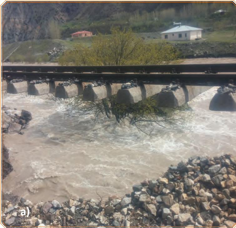
Görsel 3.30: (a,b) Taşkın sonrası altyapının kayması
