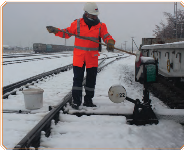
Görsel 6.2: Makas fenerinin temizlenmesi
