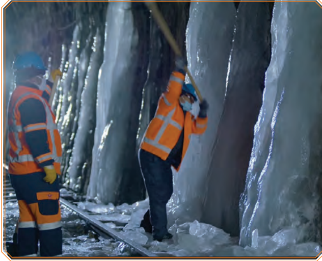
Görsel 6.11: Tünel içi sarkıt temizleme çalışması
