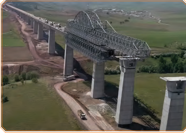
Görsel 3.15: Prefabrik tabliye montajında kullanılan kavalet
