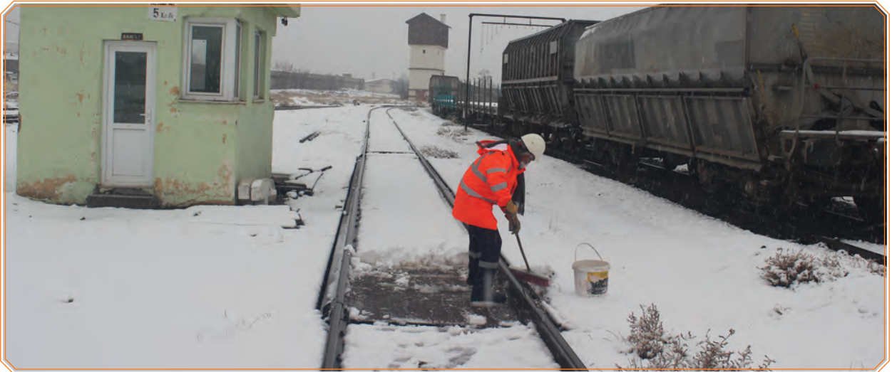
Görsel 6.9: Tartım tertibatı ve kanallarının temizlenmesi
