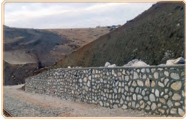
Görsel 5.7: Taş duvar istinat duvarı
