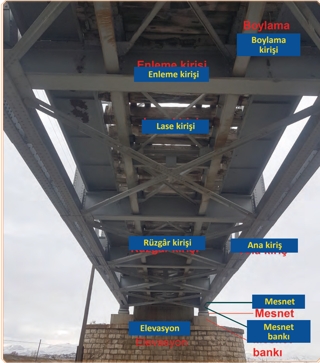
Görsel 3.28: Çelik köprünün alttan görünüşü ve elemanları
