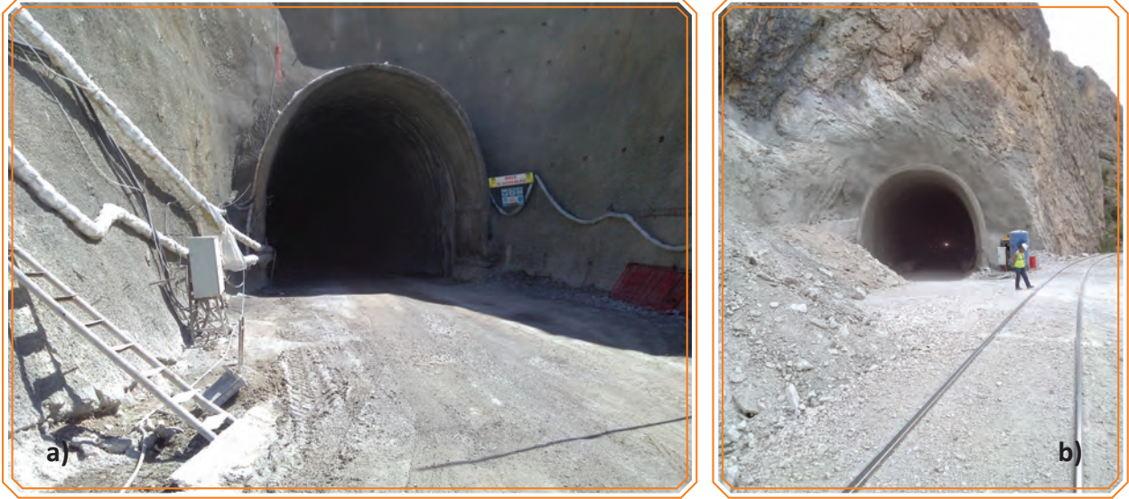
Görsel 2.12: (a,b) Tünel yapımı
