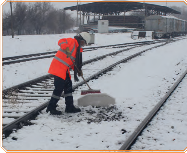
Görsel 6.7: Limit taşının temizlenmesi
