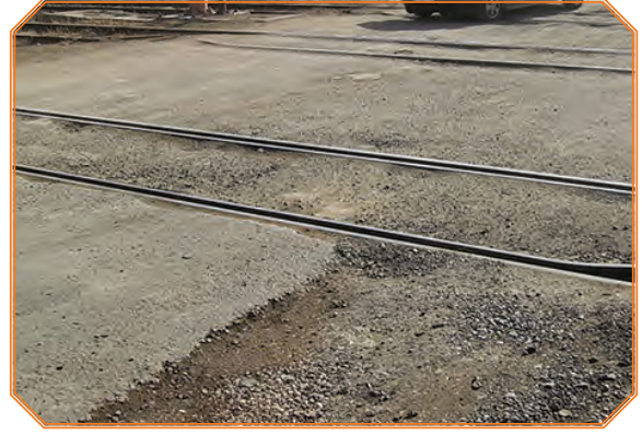
Görsel 4.8: Asfalt kaplamalı hemzemin geçit
