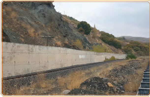
Görsel 5.6: Betonarme istinat duvarı
