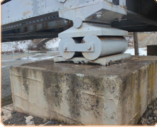
Görsel 3.11: Hareketli mesnet ve mesnet bankı
