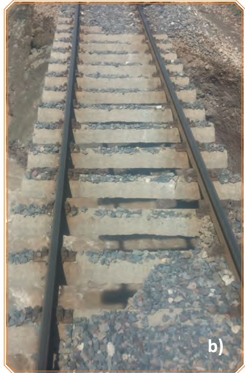
Görsel 3.30: (a,b) Taşkın sonrası altyapının kayması
