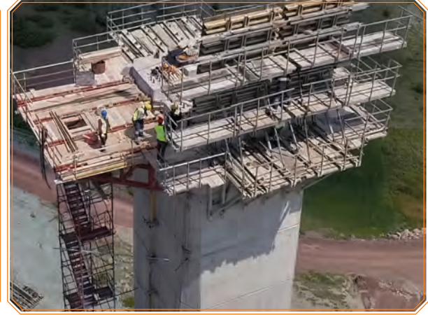
Görsel 3.16: Köprü ayağı inşaatı kavaleti
