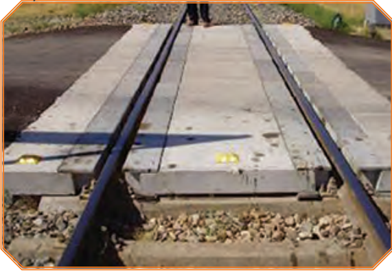
Görsel 4.9: Prefabrik kaplamalı hemzemin geçit
