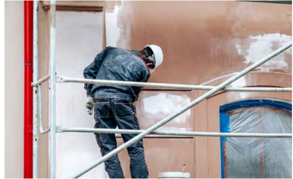
Görsel 3.76: Restorasyon için dış cephenin hazırlık çalışması
