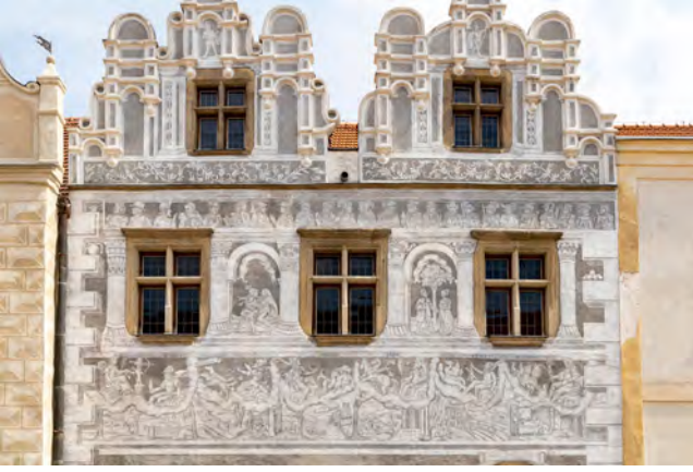
Görsel 3.34: Sgraffito tekniği ile dış cephe duvar süsleme örneği
