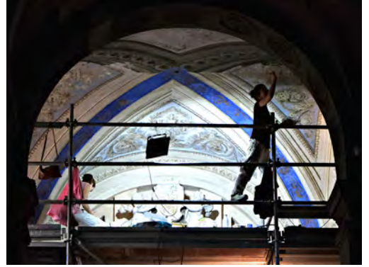
Görsel 3.60: İtalya Santa Maria Kilisesi tavanındaki freskler üzerinde restorasyon çalışması
