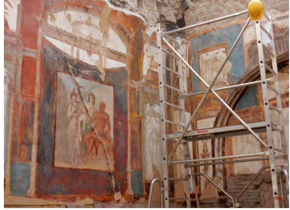
Görsel 3.58: Restorasyon çalışması için iç mekân yüzey hazırlığı
