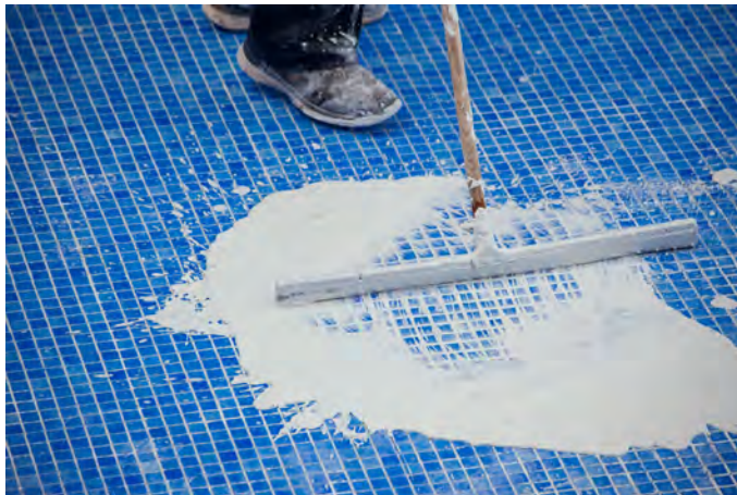
Görsel 4.77: Dış mekân mozaik çalışmasında derz işlemi
