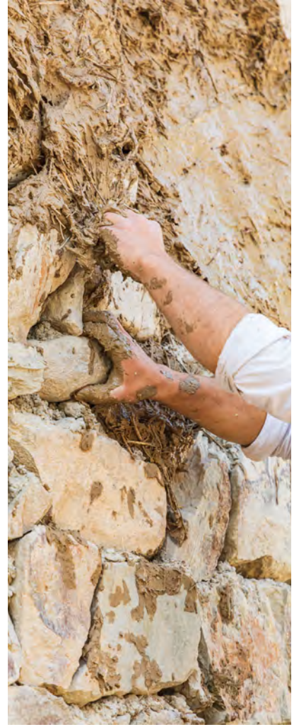
Görsel 3.46: Kerpiç sıva ile duvardaki boşlukları doldurma çalışması
