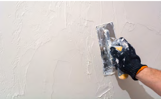
Görsel 3.44: Duvara mala ile sıva çekme işlemi
