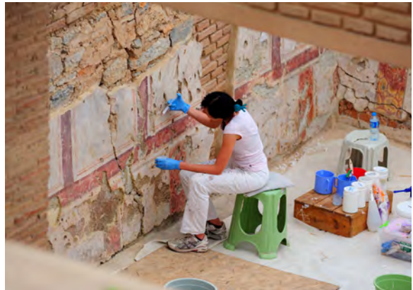
Görsel 3.77: Tarihi bir yapının yüzeyindeki boşluklara uygun malzeme ile dolgu işlemi çalışması
