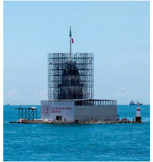
Görsel 3.61: İstanbul Kız Kulesi sağlamlaştırma amaçlı restorasyon çalışması
