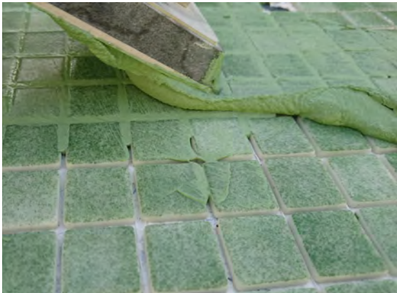
Görsel 4.80: Yüzeyde derz dolgu işlemi
