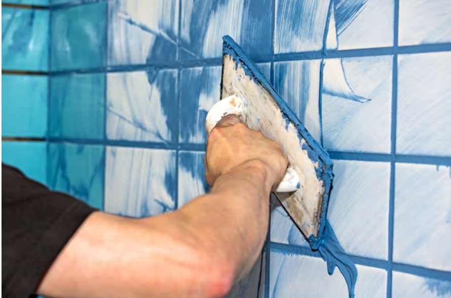
Görsel 4.74: Renkli derz ile dolgu işlemi
