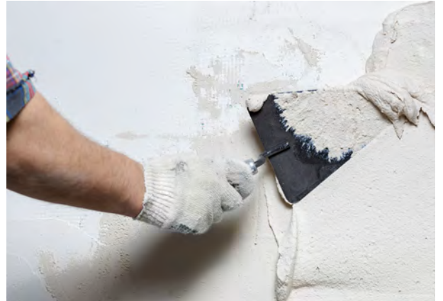
Görsel 3.48: Duvara mala ile alçı sıva çekme işlemi
