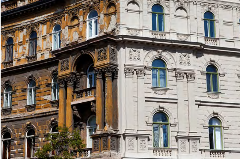
Görsel 4.43: Mimari restorasyon çalışması
