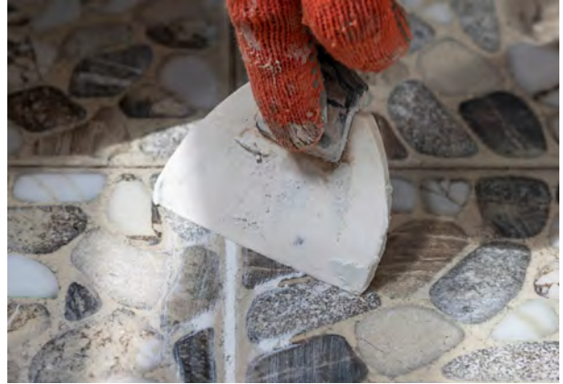
Görsel 4.79: Yüzeyde derz dolgu işlemi
