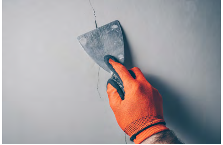
Görsel 4.51: Çatlak yüzeyin dolgu malzemesi ile doldurulması
