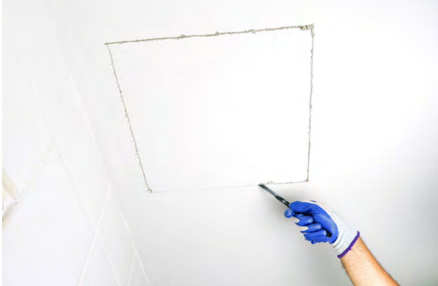
Görsel 3.82: Beyaz sıva katının kesilerek kazıma hazırlığı
