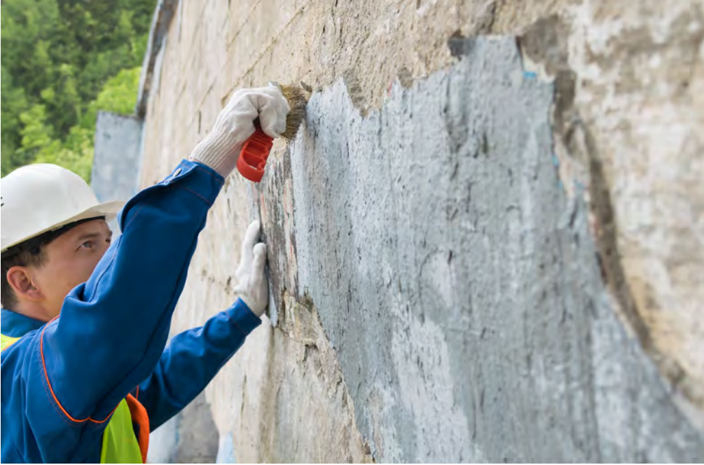
Görsel 3.81: Restorasyon uygulama yüzeyinin fırça ile temizlenmesi
