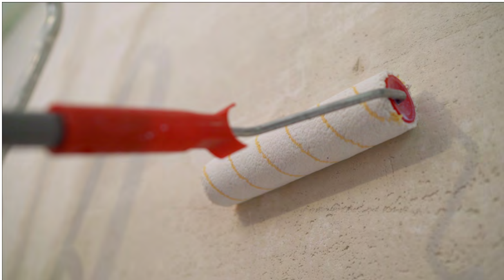
Görsel 3.83: Duvar yüzeyine rulo ile su bazlı boya sürme işlemi
