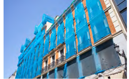
Görsel 3.68: Restorasyon çalışması için bina yüzeyinin kapatılması
