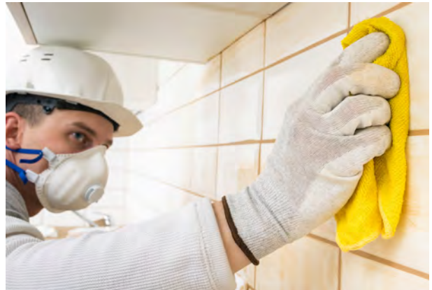
Görsel 4.81: Derz dolgu işleminden sonra yüzeyin temizlenmesi
