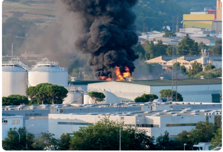
Görsel 2.6: Hasar gören iş yeri
