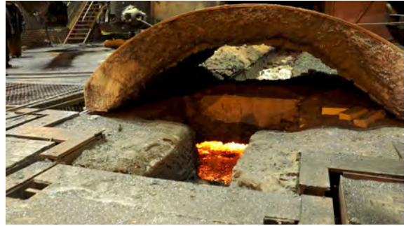
Görsel 6.4: Kanal harcı ve refrakter malzeme ile kanal yapımı
