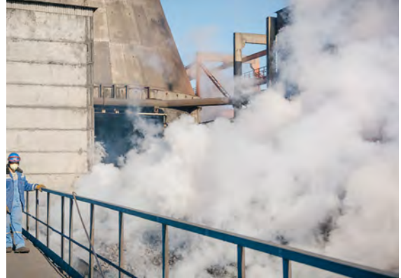
Görsel 3.5: Basınçlı su ile söndürme ünitesi
