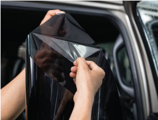
Görsel 4.59: Taşıyıcı folyonun kaldırılması
