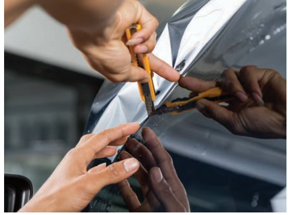
Görsel 4.58: Yüzeyden kalıplı ve taşmalı kesim
