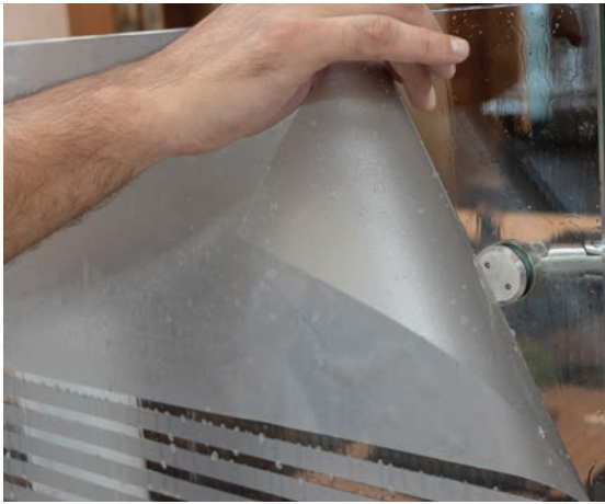
Görsel 3.9: Cam üstü kumlanmış folyo
