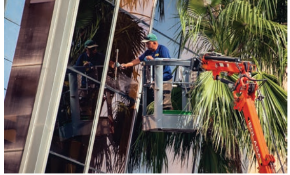
Görsel 4.32: Uygulama öncesi sepetli vinçle temizlik
