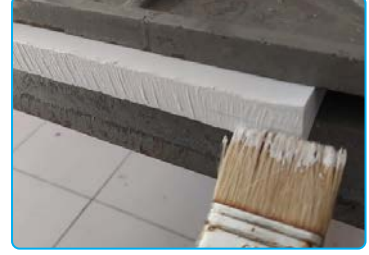
Görsel 6.19: Sırta çentik açarak tutkal sürme
