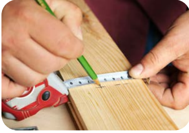
Metre ile markalama
