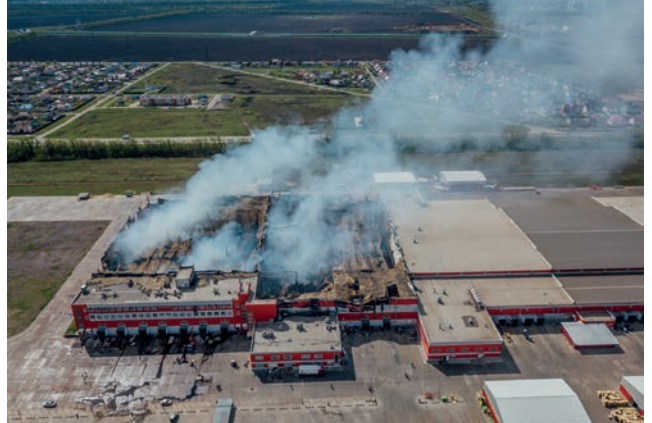
Görsel 7.5: Yangından zarar görmüş fabrika
