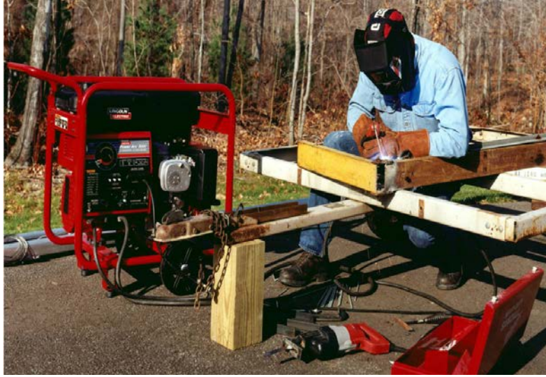
Görsel 6.1: Elektrik ark kaynağı ile tadilat yapımı
