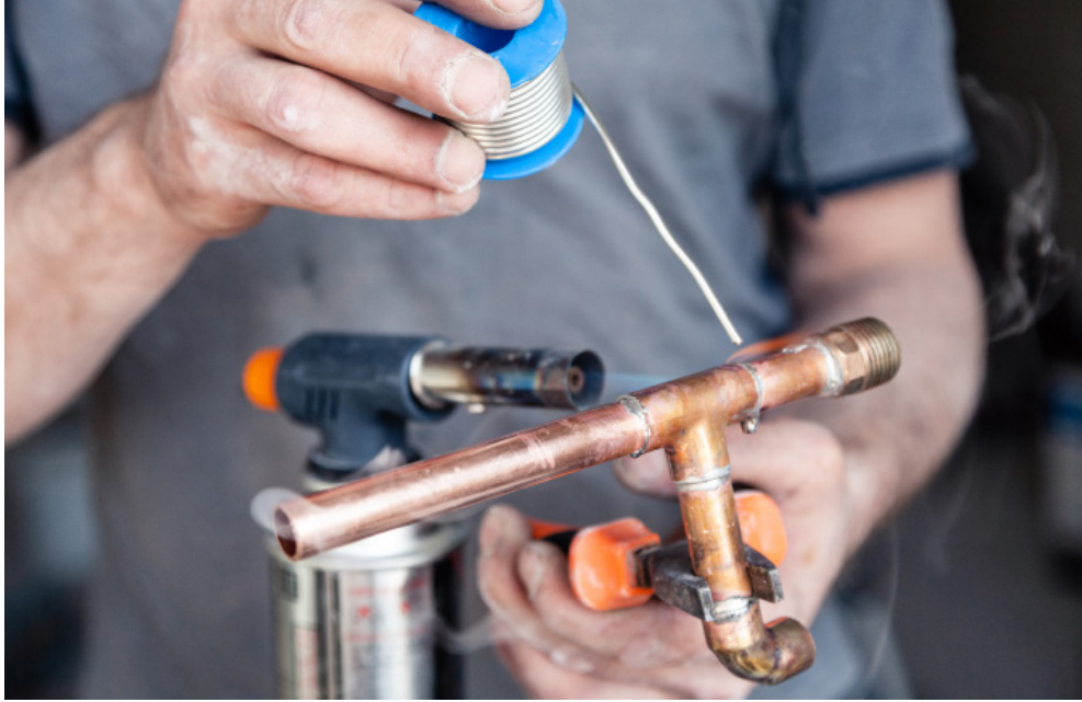
Görsel 4.2: Gaz ısıtmalı hayva
