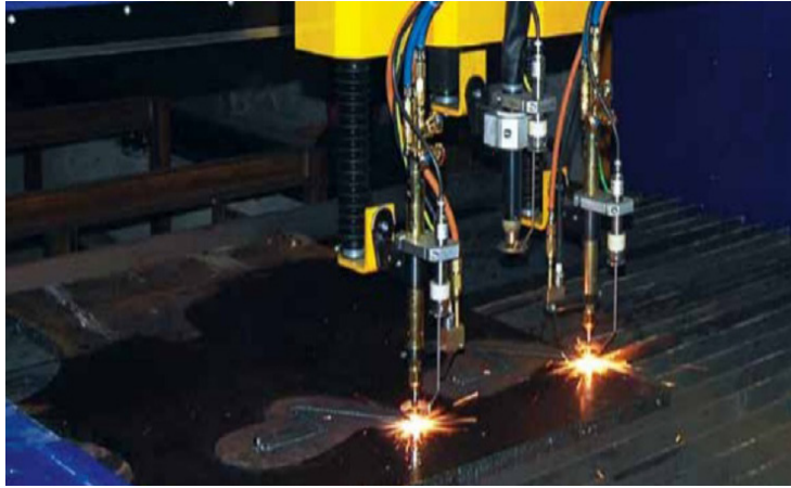
Görsel 3.6: Makine ile yapılan oksî-gaz kesimi
