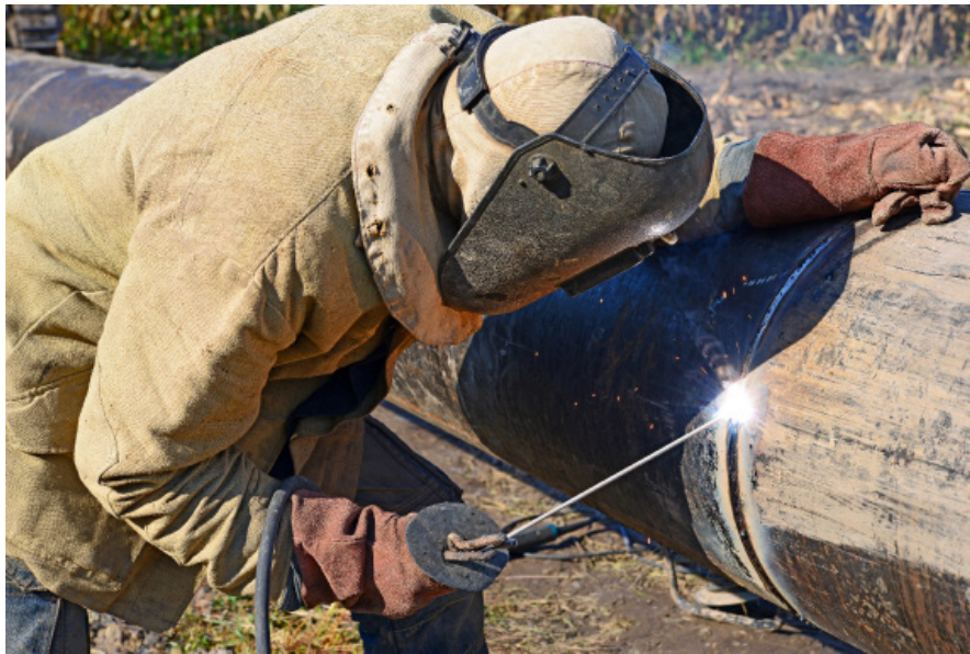
Görsel 9.4: Farklı pozisyonda tamir kaynağı uygulaması
