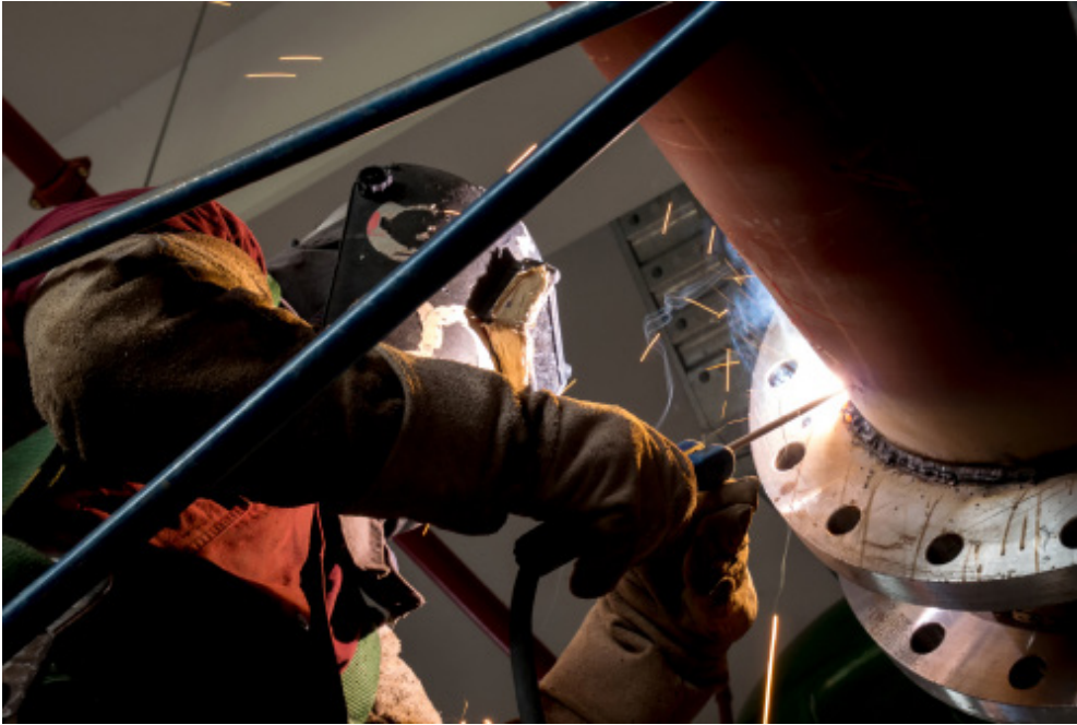
Görsel 9.5: PH pozisyonunda kaynak uygulaması
