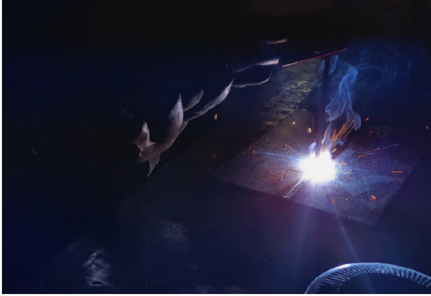
Görsel 7.2: Yatayda küt ek kaynağı uygulaması
