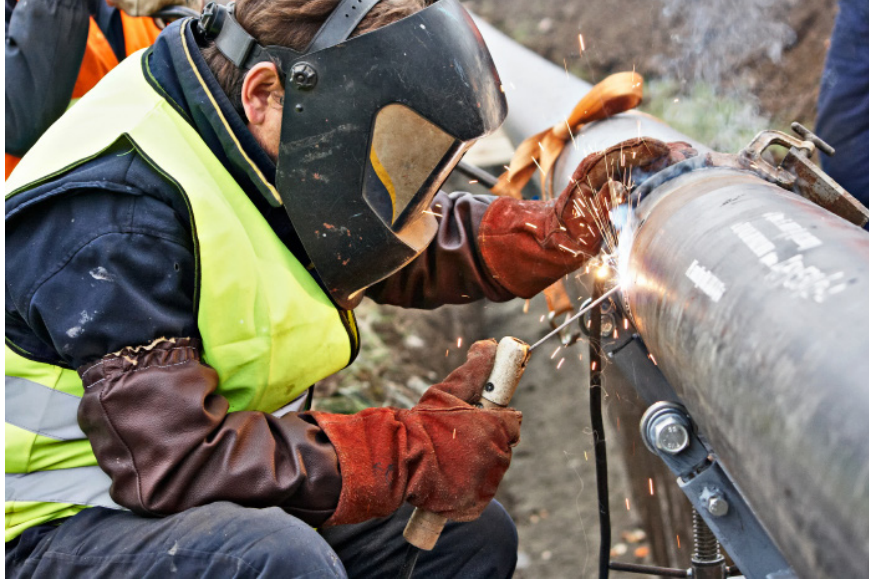
Görsel 9.3: Boru kaynağı uygulaması
