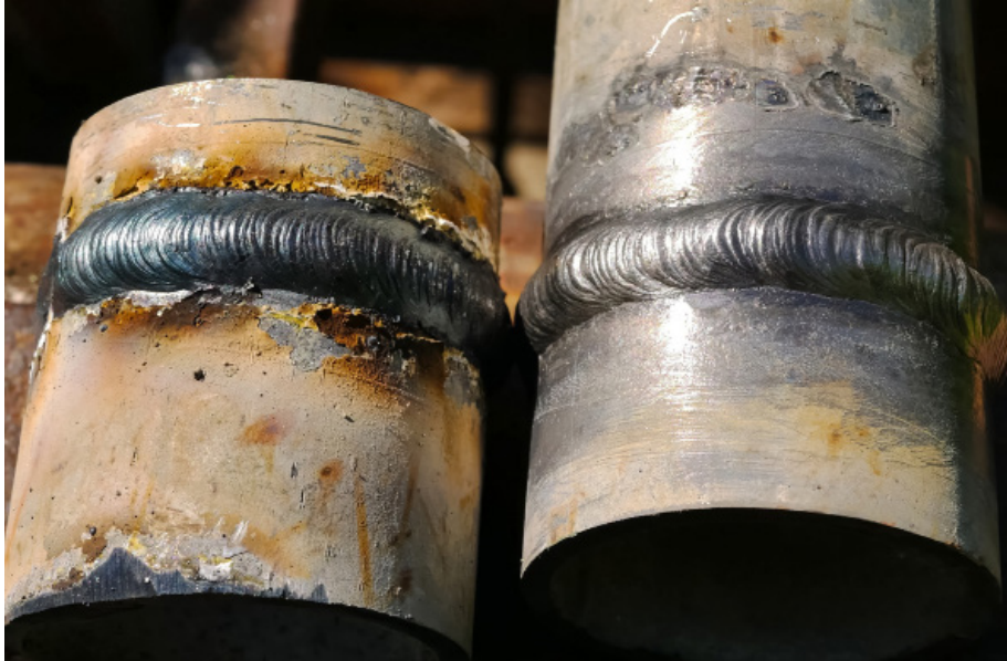
Görsel 9.7: Tamamlanmış boru kaynakları
