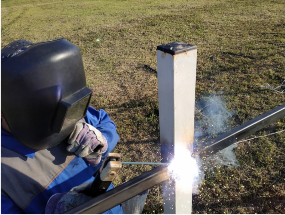
Görsel 9.10: Yatayda profillerin köşe kaynağı uygulaması
