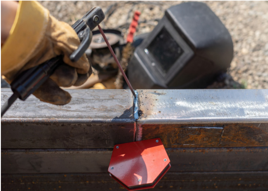
Görsel 9.9: Yatayda profil ve boruların kaynağı
