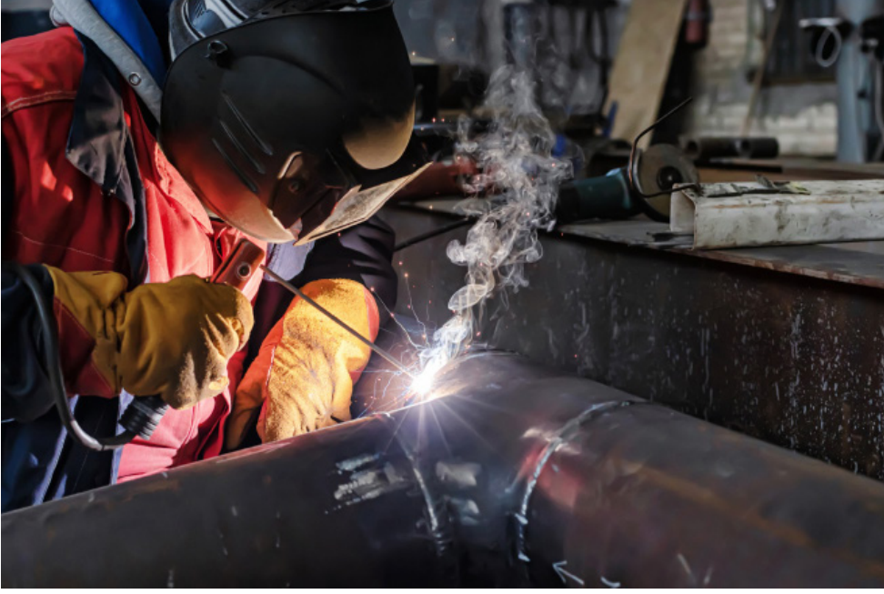
Görsel 9.8: Boru T kaynağı uygulaması
