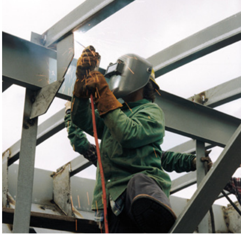
Görsel 6.3: Farklı pozisyonda yapılan kaynak uygulaması
