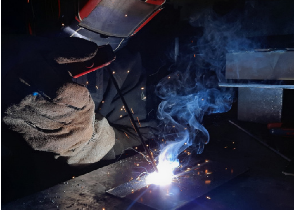
Görsel 7.4: Yatayda bindirme kaynağı uygulaması
