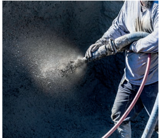
Görsel 7.7: Beton tahkimat
