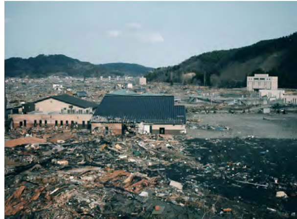
Görsel 3.13: Tsunami sonrasında oluşan yıkıntılar
