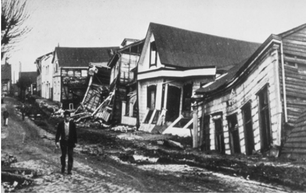
Görsel 3.6: 1960 Şili depreminde yıkılan evler
