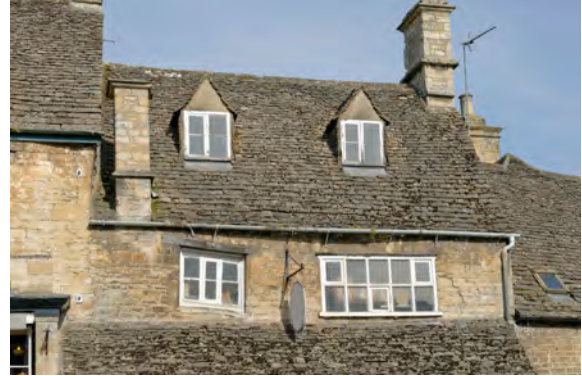
Görsel 1.31: Zemindeki organik içeriklerden dolayı binada görülen çökme olayı ve evin pencerelerinde oluşan hasar.
