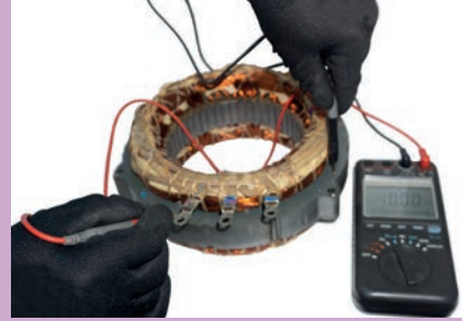
Görsel 7.13: Stator sargılarının şasiye kaçak kontrolü
