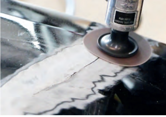
Görsel 3.40: Hasarlı bölgenin zımparalanması
