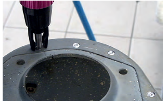
Görsel 2.23: Amortisör kulesi üzerinde punta çürütme
