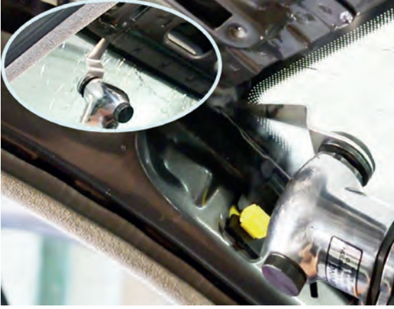
Görsel 2.30: Cam yapışkanının kesilmesi
