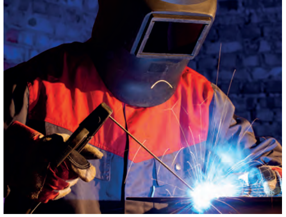
Görsel 1.18: Elektrik ark kaynağı
