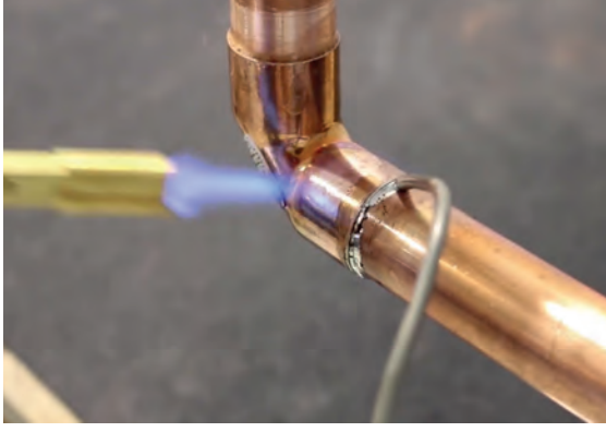
Görsel 1.114: Bakır boruların sızdırmaz lehimlenmesi
