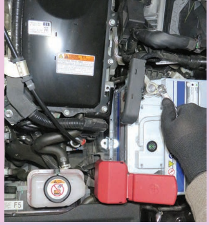
Görsel 8.15: Akü bağlantılarının sökülmesi
