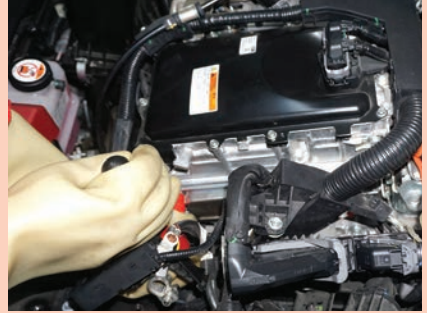
Görsel 1.31: İnvörtör yan kapağının sökülmesi
