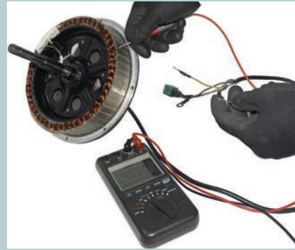
Görsel 6.16: Stator sargılarının şasiye kaçak kontrolü
