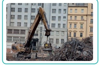
Görsel 3.1: Bir yıkım işleminden sonra demir malzemelerin mıknatıs ile yığından ayrılması
