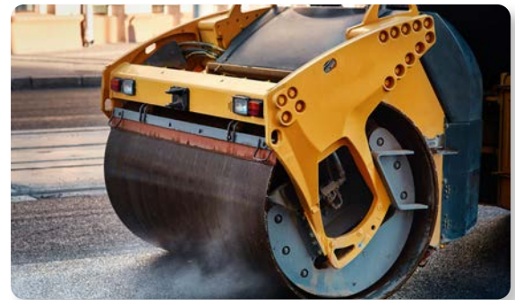
Görsel 6.3.2: Sıcak asfalt ile yol yapılması
