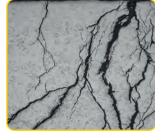
Görsel 1.8: Stres korozyonu sonucu oluşan çatlak
