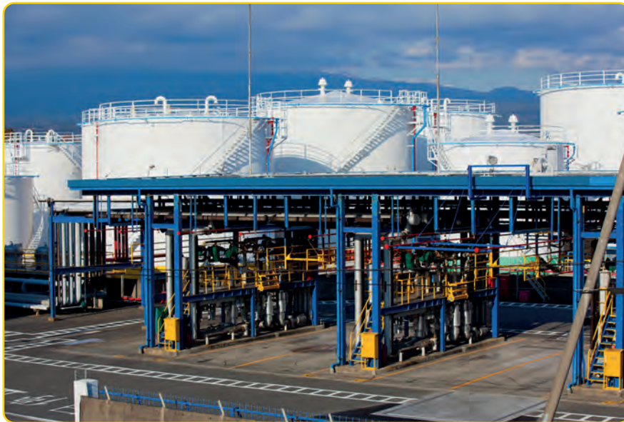
Görsel 2.15: Rafineri ana boru hattı ve dolum istasyonu
