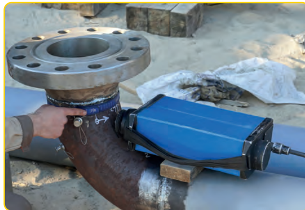
Görsel 1.11: Radyografi yöntemi ile korozyon kontrolü
