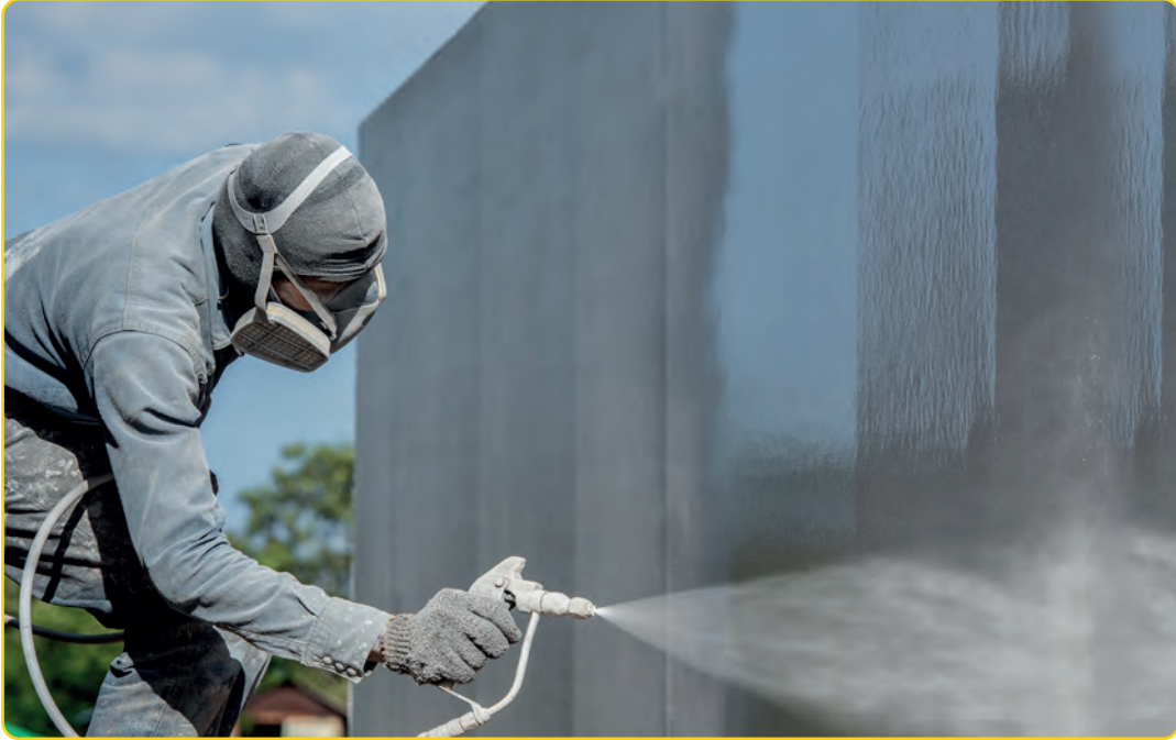
Görsel 1.23: Metal yüzeyi püskürtme tabancası ile boyama
