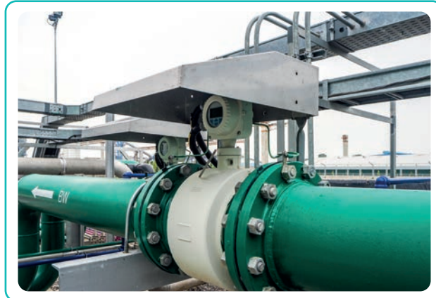
Görsel 3.9: Elektromanyetik debimetre
