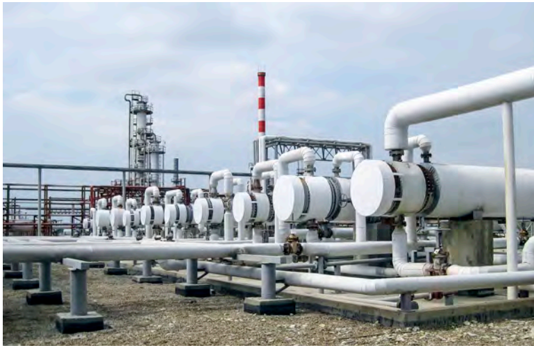
Görsel 5.6: Rafineride kullanılan ısı deęiřtiriciler
