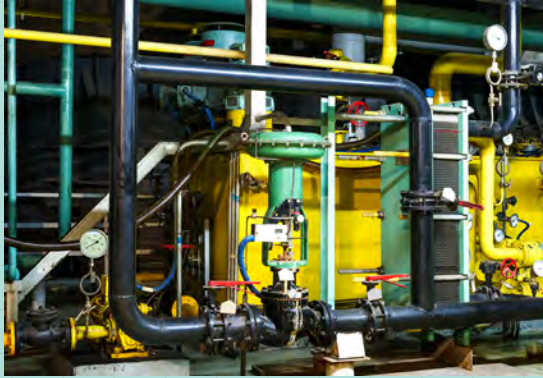
Görsel 1.9: Kalorifer sistemlerinde kullanılan vanalar
