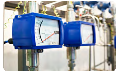
Görsel 1.4: Metal ve tüplü rotametreler
