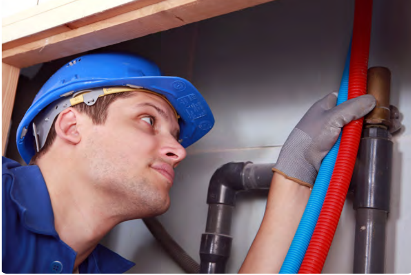
Görsel 1.9: Su tesisatındaki kaçakların kontrolü
