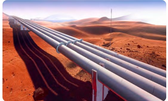
Görsel 7.5: Doğal gaz boru hattı
