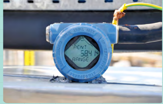
Görsel 4.2: Basıncı ölçen transmittter
