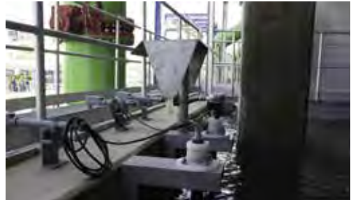
Görsel 6.3: Soğutma kulesi havuzunda iletkenlik ve pH ölçme ekipmanı
