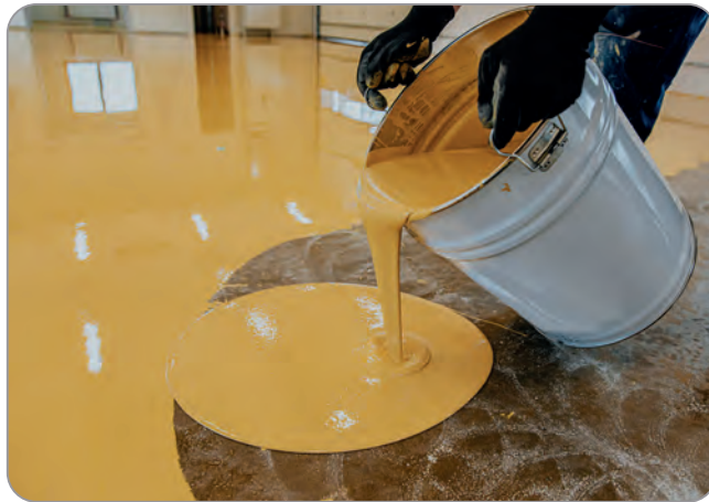
Görsel 3.2: Epoksi reçinenin zemine uygulanması
