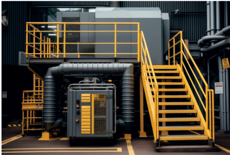
Görsel 6.11: Karbon karası depolama tesisi
